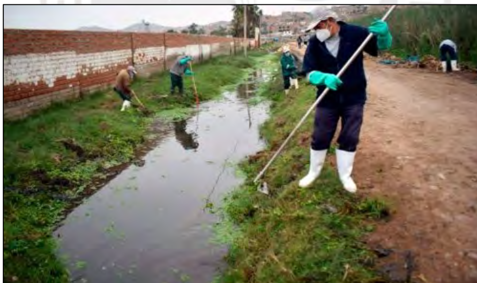
Figura 3. Limpieza manual de canales de humedales
