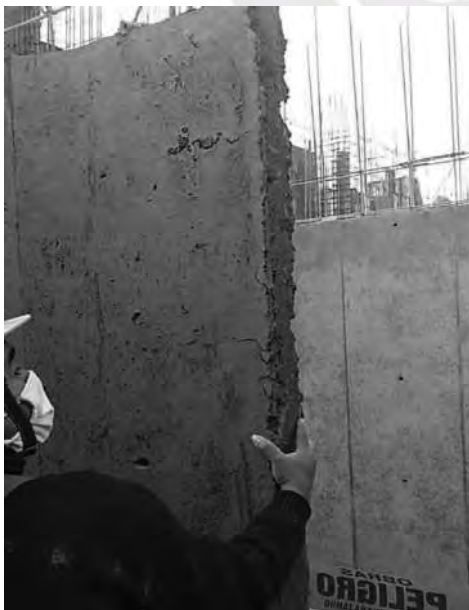
Figura 1. Retardo de fraguado en muros Elaboración propia
