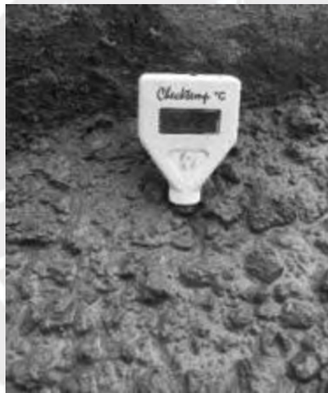
Figura 10. Ensayo de temperatura del concreto
