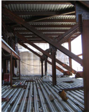
Ilustración 16: Diagonales de acero del sistema outrigger (Callow et al., 2009)
