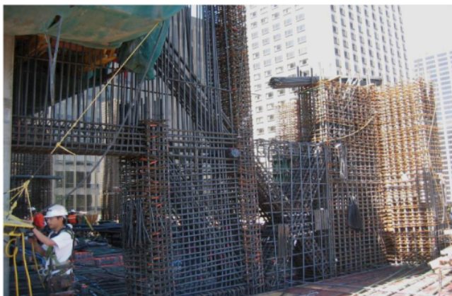
Ilustración 18: Construcción de muro outrigger (Choi et al., 2012, p.53)
