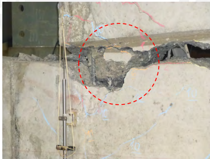
Figura 3.17: Estado final de las barras con continuidad en el muro
