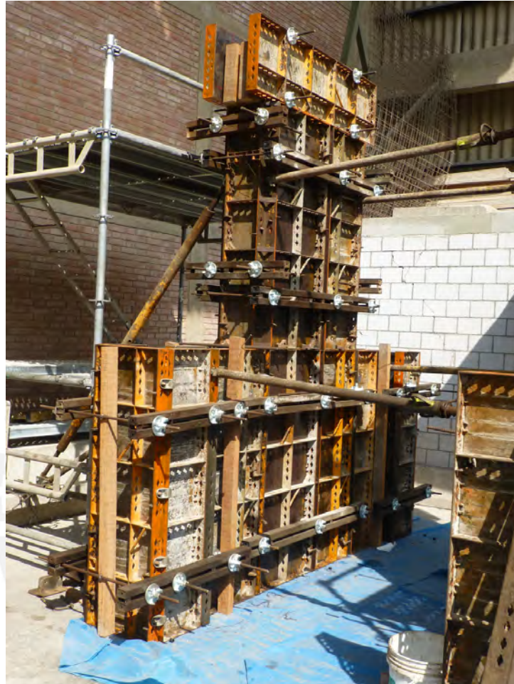
Figura 3.9: Encofrado metálico empleado en el vaciado del concreto
