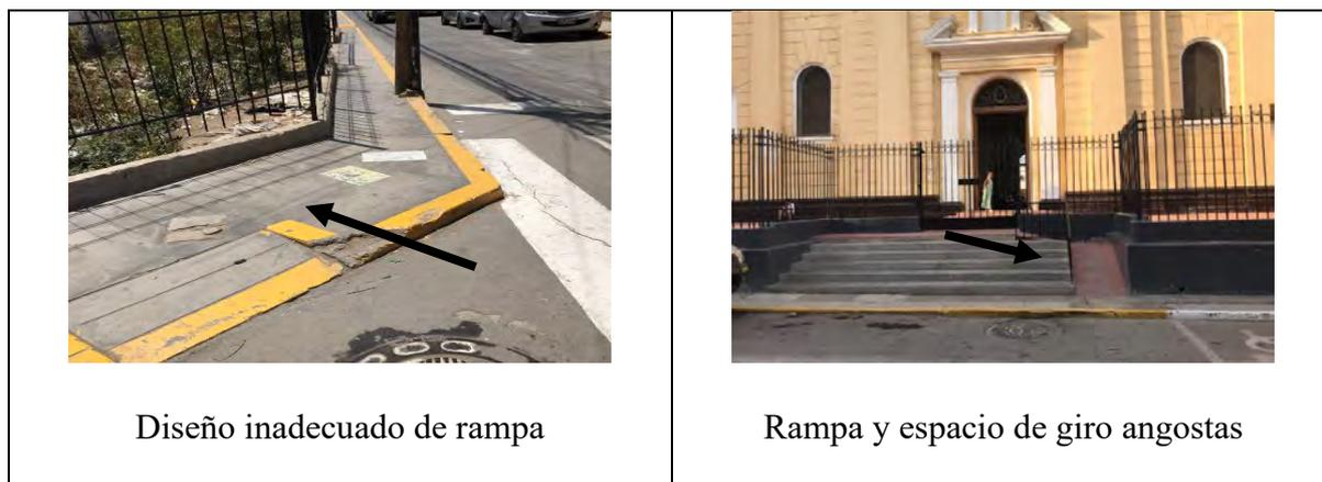
Figura 68. Diseño de veredas y rampas no acorde a la escala humana
