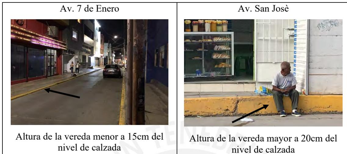
*Figura 51. Diseño incorrecto entre altura de vereda y calzada*
