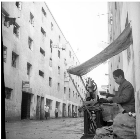
Figura 14. Obrero laborando en el barrio El Porvenir Fuente: El Comercio (1961)
