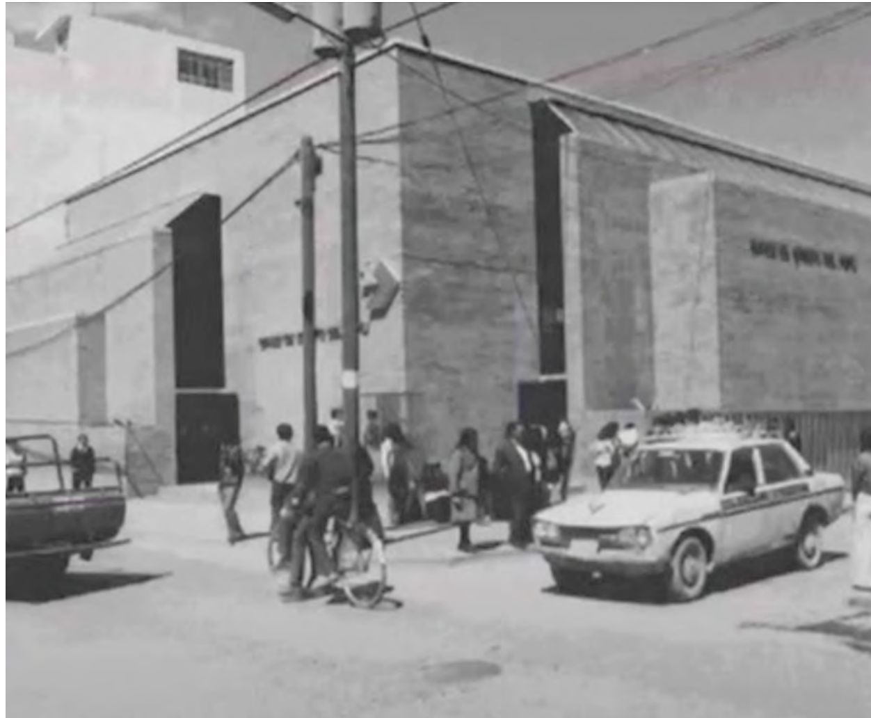
figura 12: Vista exterior fuente: Conferencia Guillermo Málaga: "Obra 1965-2020" (AAPUCP, 2022)
