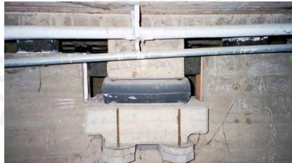
**Figura 2.3:** *Aislador usado en el Pestalozzi School. Tomado de Naeim y Kelly (1999).*
