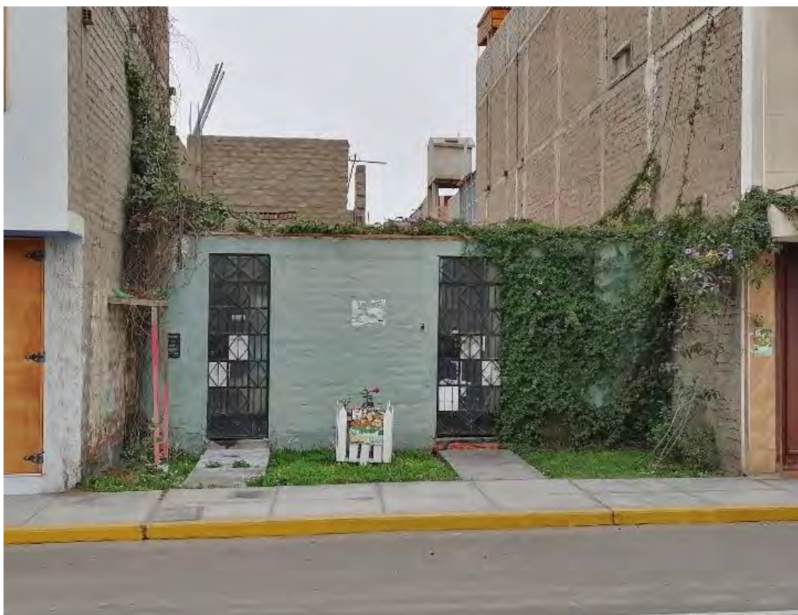
Figura 3. Fachada inicial del módulo de vivienda. Nótese la ausencia de ornamentos, los dos ingresos y la ubicación del jardín en la parte frontal. Año: 2021. Fuente: María de la Piedra.
