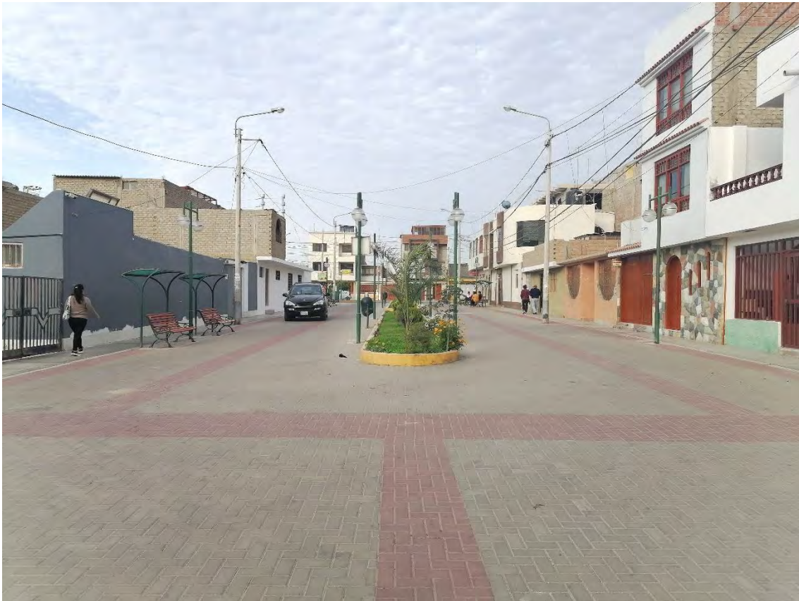
Figura 15. Alameda central con tratamiento. Nótese la gran diferencia de proporción entre el área asfaltada y el área verde. Año: 2021. Fuente: María de la Piedra.
