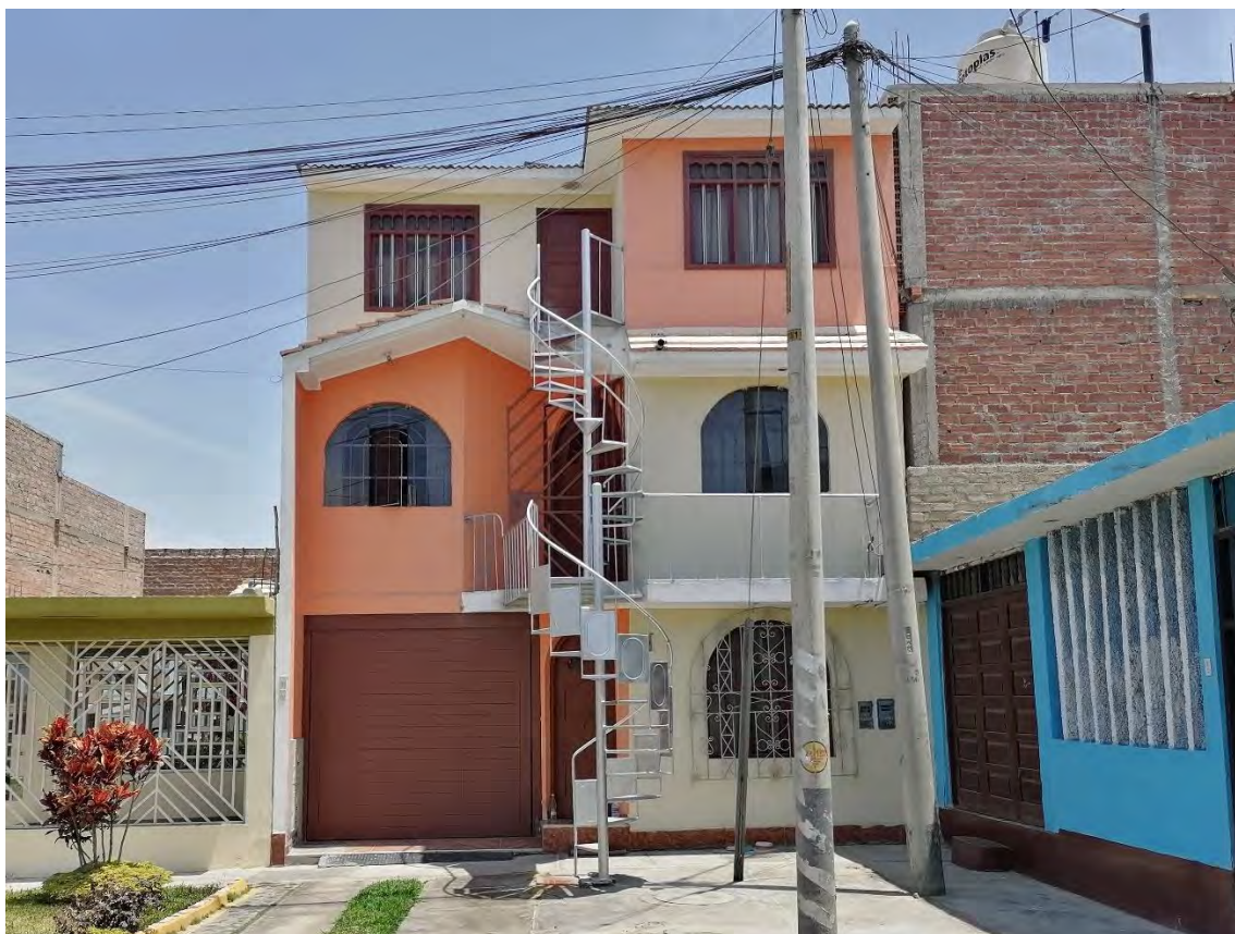
Figura 5. Fachada analizada. Nótese la presencia de la escalera fuera del terreno. Año: 2021. Fuente: María de la Piedra.
