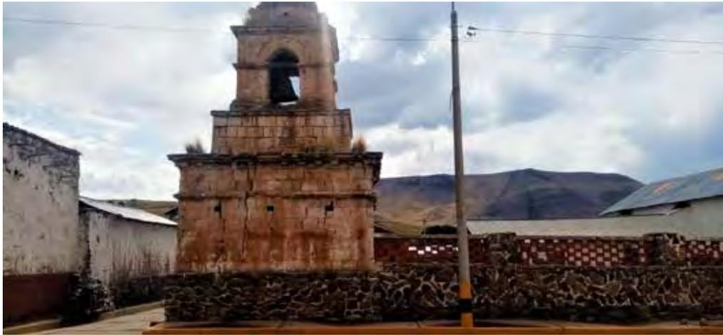
Uso de piedra en diferentes técnicas constructivas y cerco de permeabilidad variable
