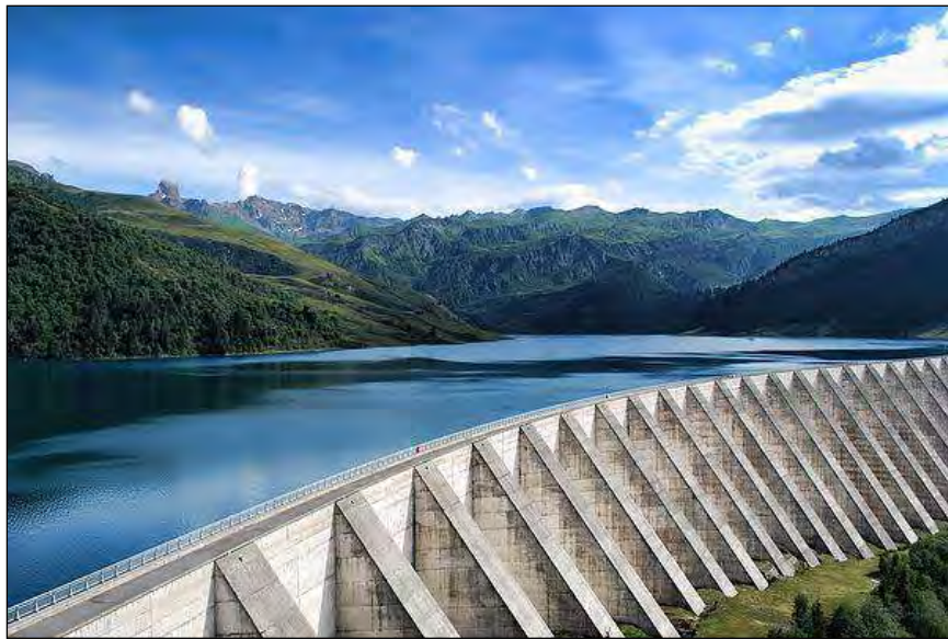
Figura 2-5 Imagen panorámica presa de contrafuertes
