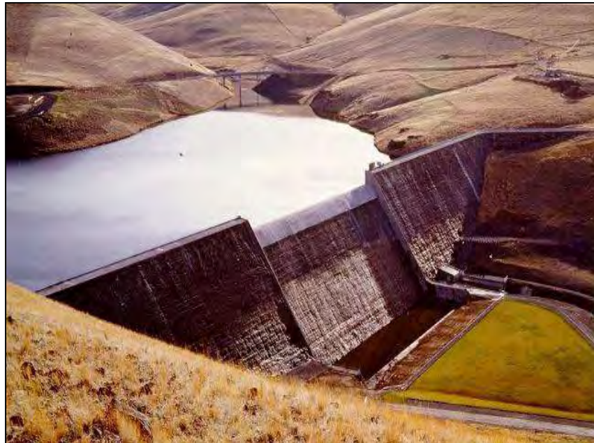
Figura 2-3 Imagen panorámica presa de gravedad.
