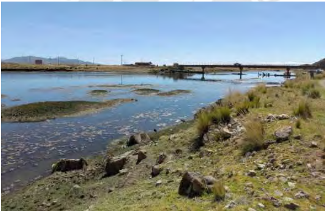
Imagen B.48. Vista panorámica del río en el punto 13 de la exploración de campo Ubicación: Aguas abajo del puente Churi: Carretera Juliaca – San Antonio.
