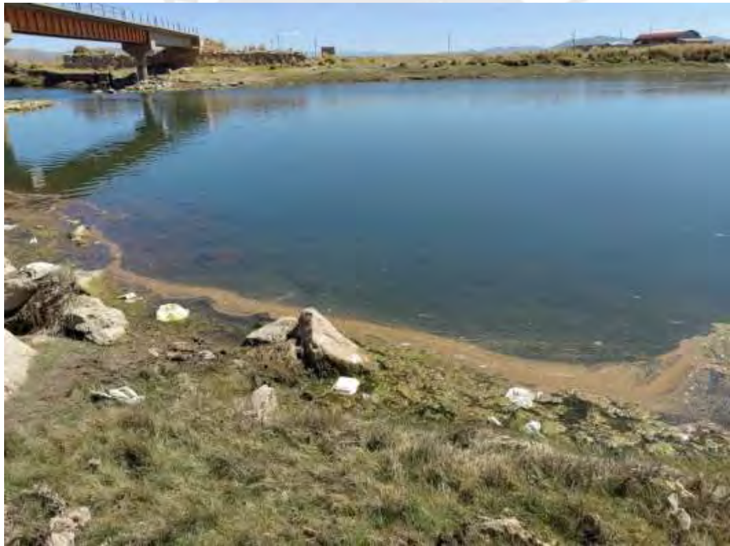
Imagen B.46. Vista transversal y material del lecho del río en el punto 12 de la exploración de campo Ubicación: Aguas abajo del puente Churi: Carretera Juliaca – San Antonio.
