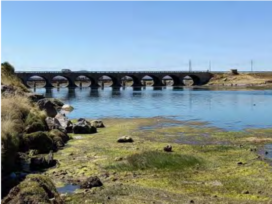
Imagen B.35. Vista panorámica de la obra de infraestructura Puente Maravillas. Ubicación: Aguas arriba del puente Maravillas – Carretera Juliaca - Pucara.
