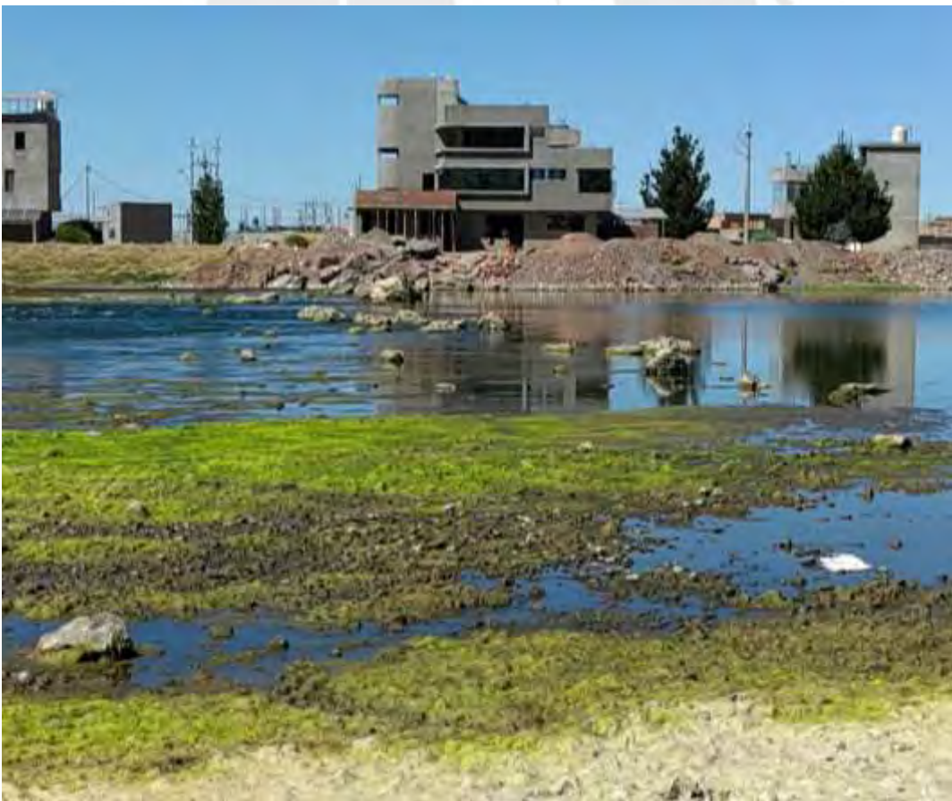
Imagen B.34. Vista transversal aguas abajo del punto 9, se ubican obstrucciones al cauce del río. Ubicación: Aguas arriba del puente Maravillas – Carretera Juliaca - Pucara.
