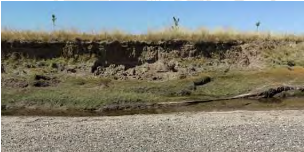
Imagen B.30. Vista del material de lecho del cauce en la zona de excavación y separación del río. Ubicación: Punto 8 en la exploración
