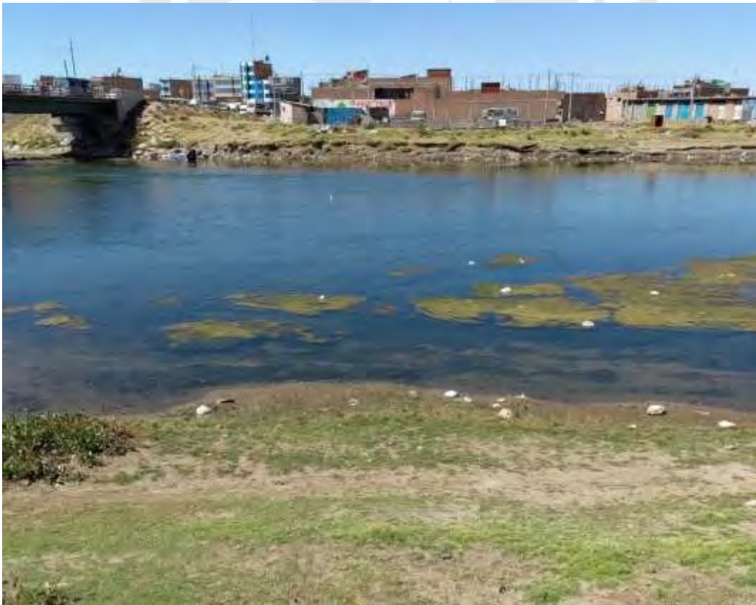
Imagen B.44. Vista transversal y material del lecho del río en el puente Independencia. Ubicación: Aguas abajo del puente Independencia: Carretera Juliaca - Huancané.
