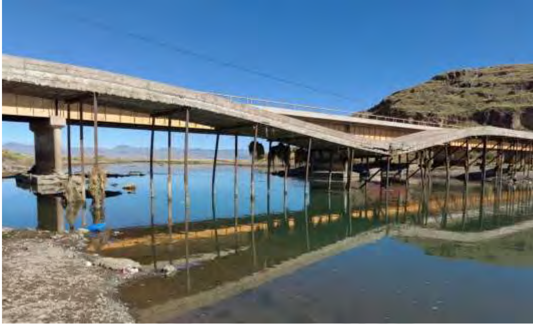
Imagen B.7. Puente Unocolla, conexión entre Juliaca y Lampa. Ubicación: Puente Unocolla, carretera Juliaca – Lampa
