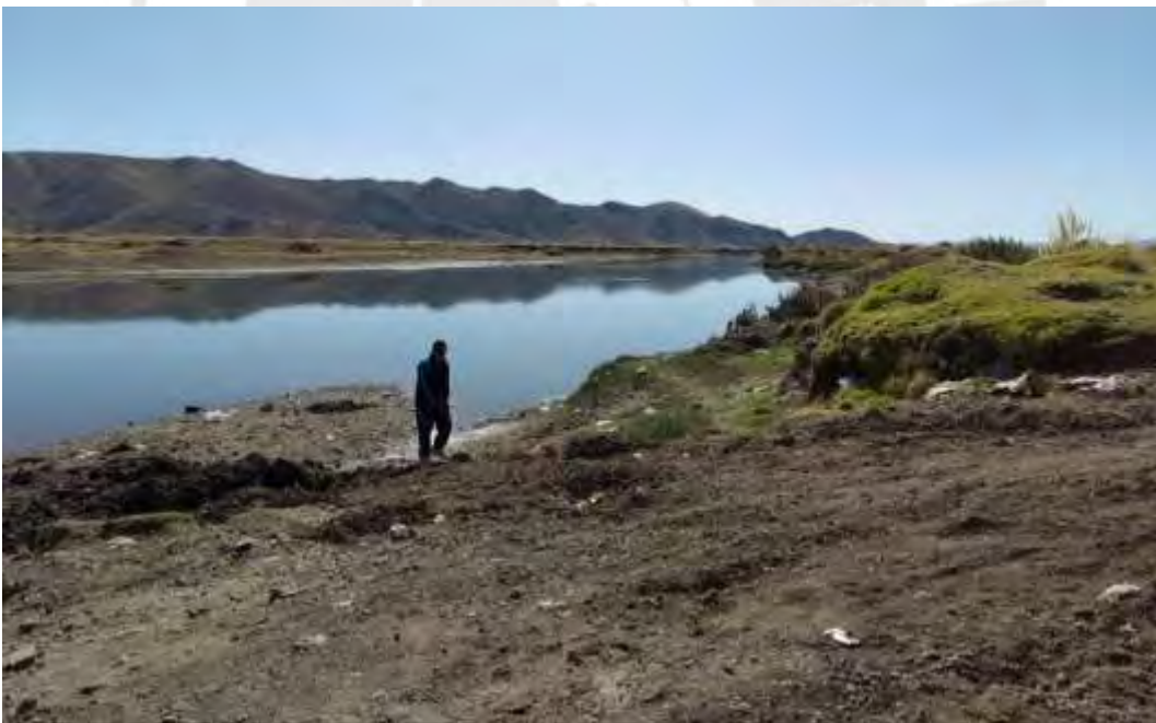
Imagen B.4. Vista panorámica del punto 2 de la visita de campo. Ubicación: Aguas abajo del puente Unocolla.
