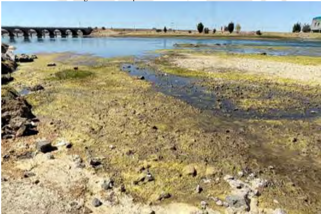
Imagen B.36. Vista panorámica del río y el puente Maravillas, aguas arriba del puente Ubicación: Aguas arriba del puente Maravillas – Carretera Juliaca - Pucara.
