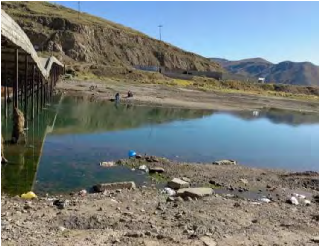
Imagen B.5. Vista de la sección transversal del río en el punto 2 de la visita de campo. Ubicación: Aguas abajo del puente Unocolla.
