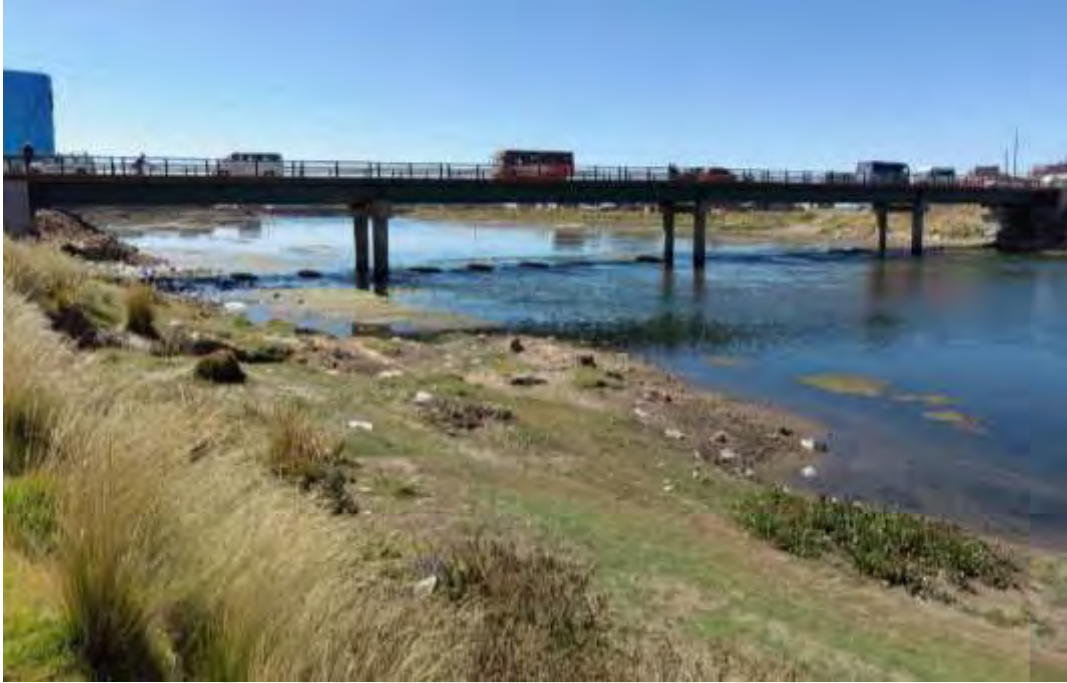
Imagen B.43. Vista panorámica del puente Independencia Ubicación: Aguas abajo del puente Independencia: Carretera Juliaca - Huancané.
