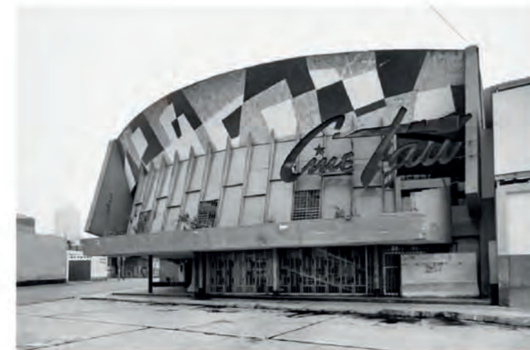
Situación actual del Cine Tauro Vista Exterior
