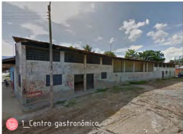
Ex almacén portuario se recicla, se reforma y se incorpora como nuevo centro gastronómico: culminación de la zona comercial.
