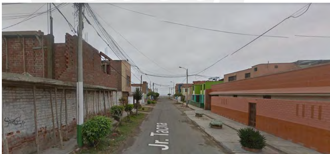
Figura 19. Vista de estado de viviendas de la zona vecina al terreno del proyecto (Jr. Tacna). Fuente: Google Earth
