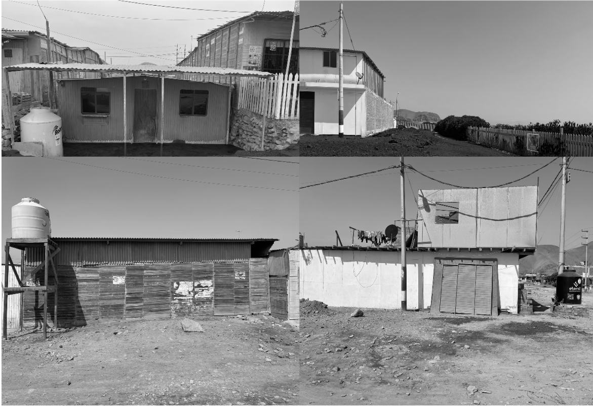
Figura 13. Tipos de materiales compuestos en la fachada. Fotografías propias.
