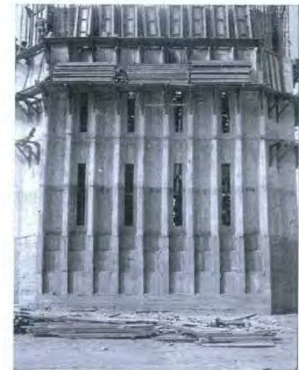
Vista de obra - Base del fanque de agua.
