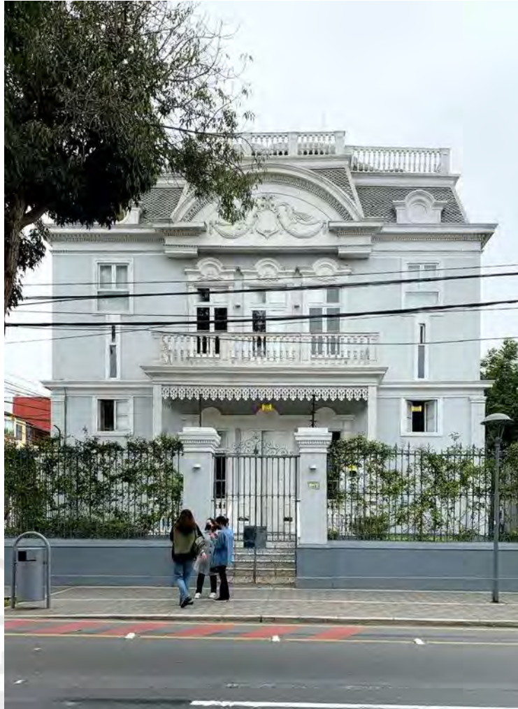
Imagen 3: Fachada Casa Apesteguía Fuente: Propia.
