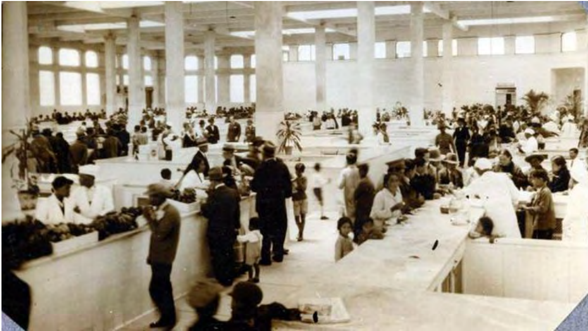
Imagen 9. El sistema de columnas y vigas permitió una continuidad visual al interior del mercado Modelo 28 de Julio. Fuente: Diario El Comercio
