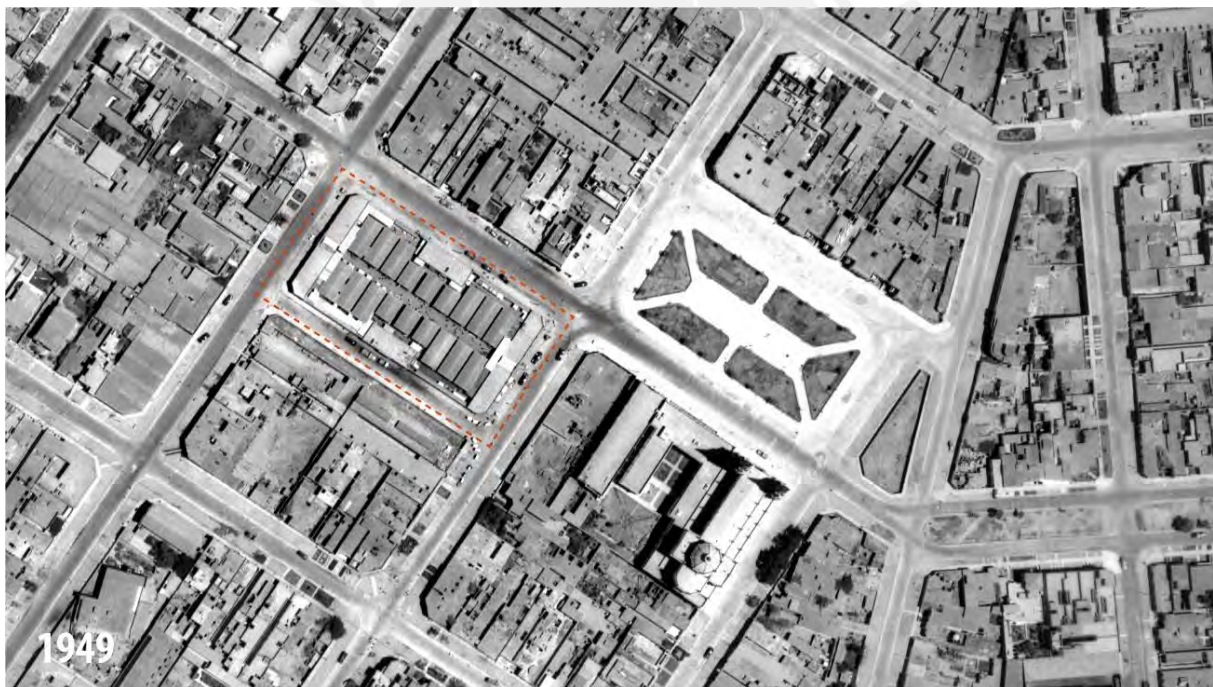
Imagen 7. En el diseño original del Mercado San José, se contempló la creación Jr. Punta Pacocha, pero no su peatonalización. Si bien se redujeron los jardines frente a las viviendas, posteriormente se arborizaron los perímetros del mercado. Fuente: Servicio Aerofotográfico Nacional, 1949.
