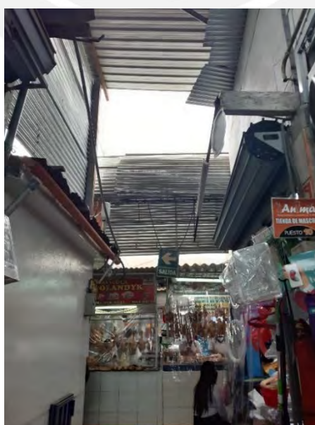
Imagen 5. Encuentro entre varios tipos de cubierta en el Mercado Anexo N°2. Fotografía propia.
