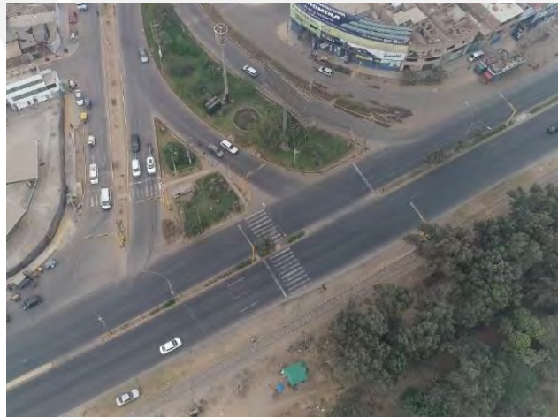
figura 72: Se muestra en la figura la falta de señales en las vías por el desgaste
