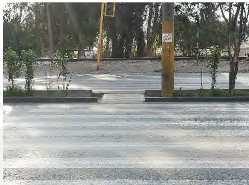
figura 78: Se ve la reducción de la mediana a comparación del paso peatonal
