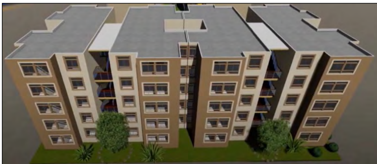
Figura 17. Vista exterior de los edificios contiguos.
