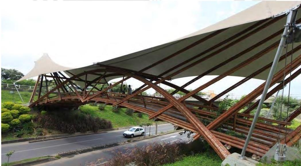
Ilustración 4: Puente en Cúcuta, Colombia. Detalle de las tirantas (La librería del ingeniero, 2010)
