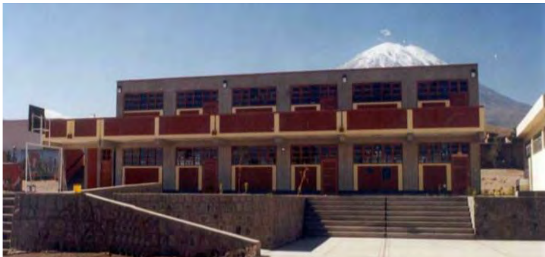
Figura 2.3. Colegio educativo típico 780 POST Tomado de “Apuntes de Ingeniería Antisísmica”, por Muñoz, 2020a.
