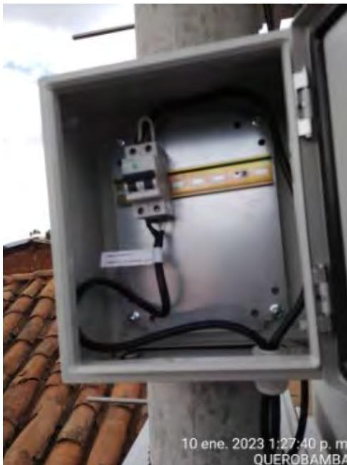
La capacidad de energía que se requiere es de 0.5KW y una llave de 16Amp para energizar a la OLT.
