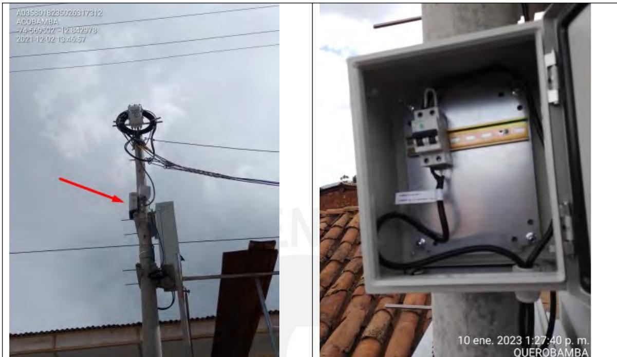
De la Figura se observa el punto donde se recibe el cable de energía con los 0.5KW, posterior a ello se conecta un cable de energía al rectificador como se muestra a continuación:
