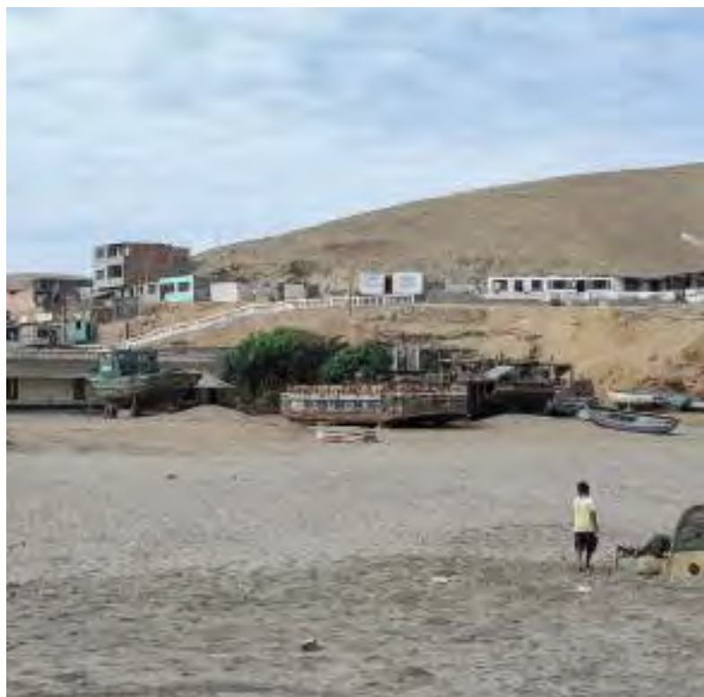
F44. Fotografía del astillero local y balneario de Supe Puerto Fuente: Luis Yupanqui (2012)
