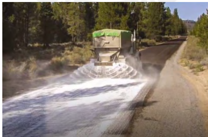
Figura 3. Control de polvo y estabilización de suelos. Estabilización mediante la aplicación de cloruros (Yepes, 2021).
