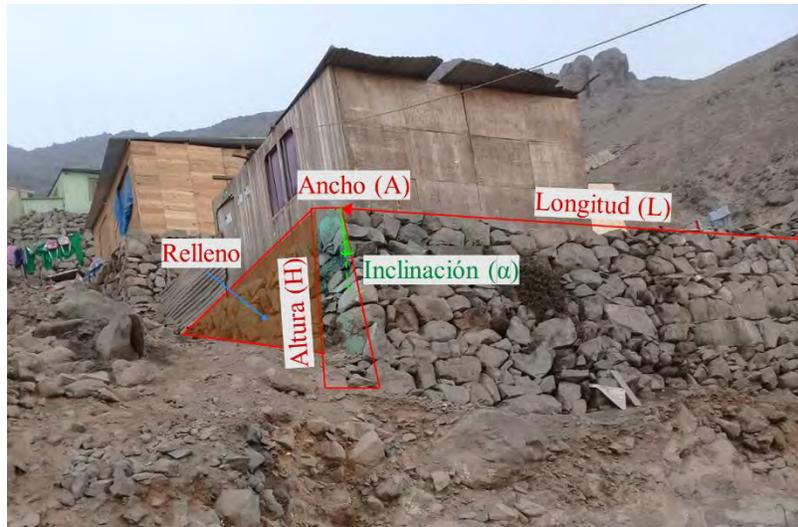
Figura 3.2. Pirca típica (Adaptado de Santa Cruz et al.)[40]
