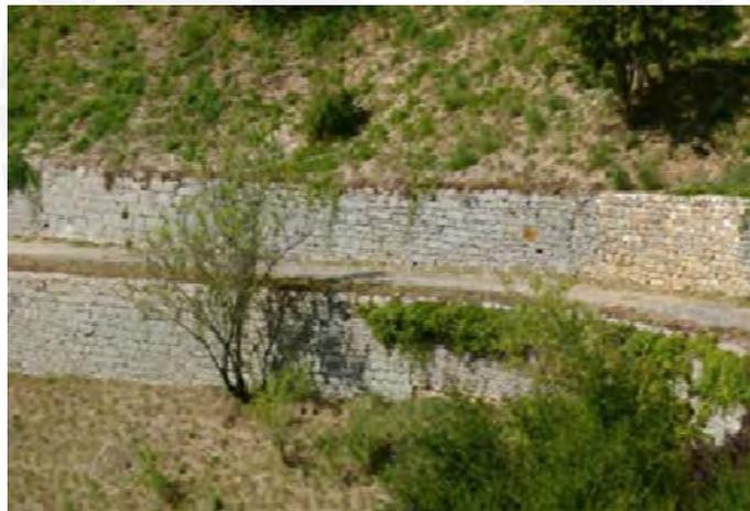
*Figura 1. 1. Muros de contención (DSRW) [1]*
