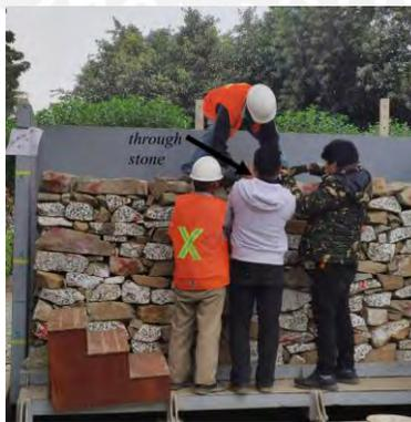
*Figura 8.12. Colocación de through-stones en la hilada superior*
