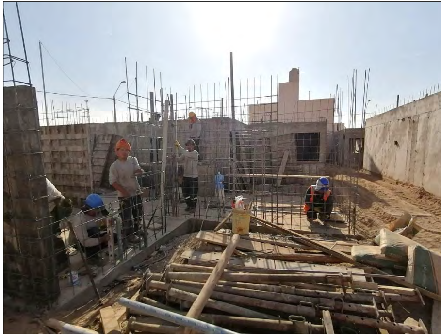
Figura 21: Colocación de la armadura de los muros. Fuente: Propia.
