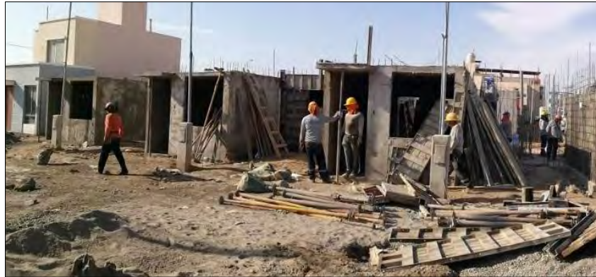
Figura 25: Desencofrado de la vivienda. Fuente: Propia.
