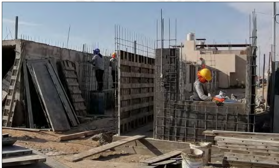
Figura 23: Colocación del encofrado en los muros de ductilidad limitada. Fuente: Propia.
