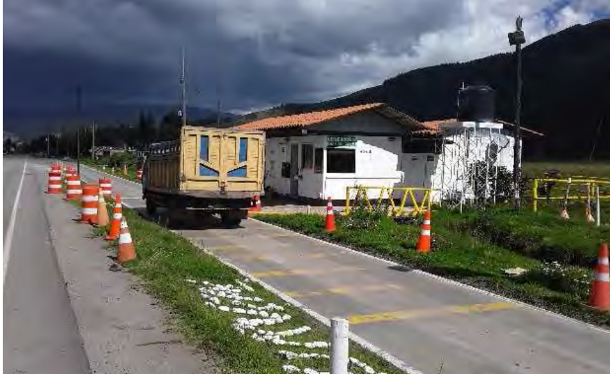
Figura 12. Estación de pesaje móvil Anta.
