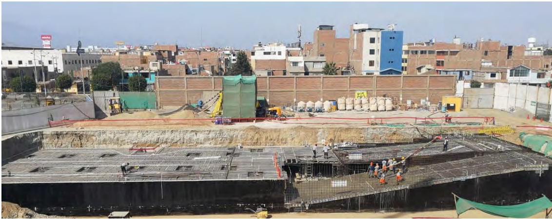
Figura 30. Fotografía del encofrado de techo del sótano 1 de Villanova Etapa 3 Fuente: Propia.
