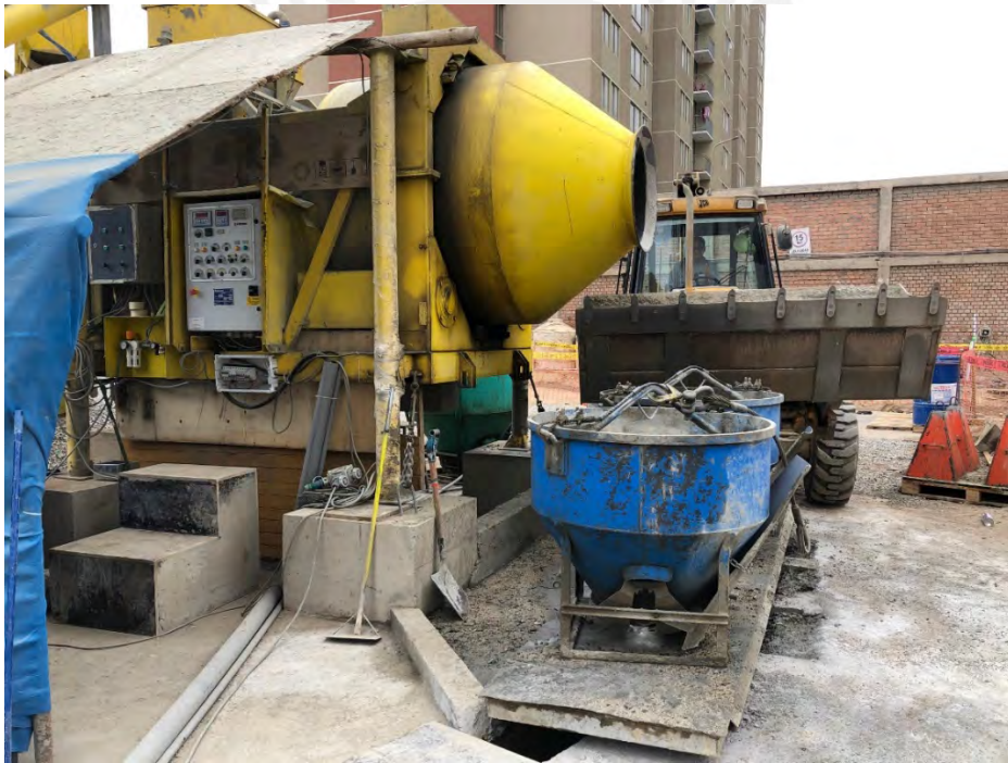
Figura 37. Retroexcavadora esperando ser atendida por la planta de concreto centralizada Fuente: Elaboración propia.
