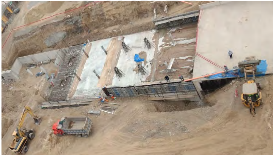
Figura 45. Vaciado de muro de sótano 1 con chute
