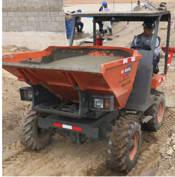
Figura 38. Dumper transportando 0.9 metros cúbicos de concreto Fuente: Propia.
