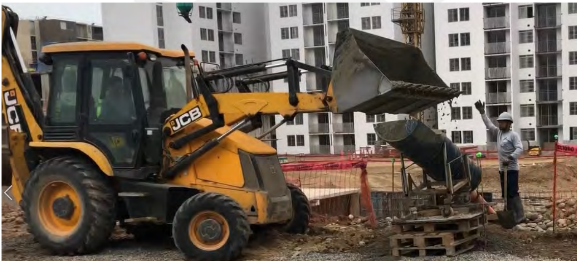
Figura 33. Fotografía de la retroexcavadora 2 vaciando concreto para la losa de techo del sótano 2 de Villanova Etapa 3
