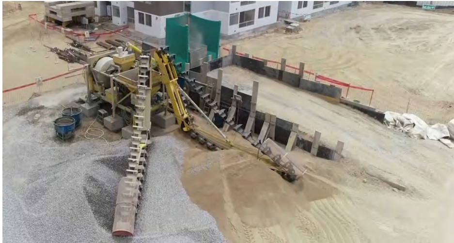
Figura 15. Zonas de carga de cemento y acopio de agregados Fuente: propia.
