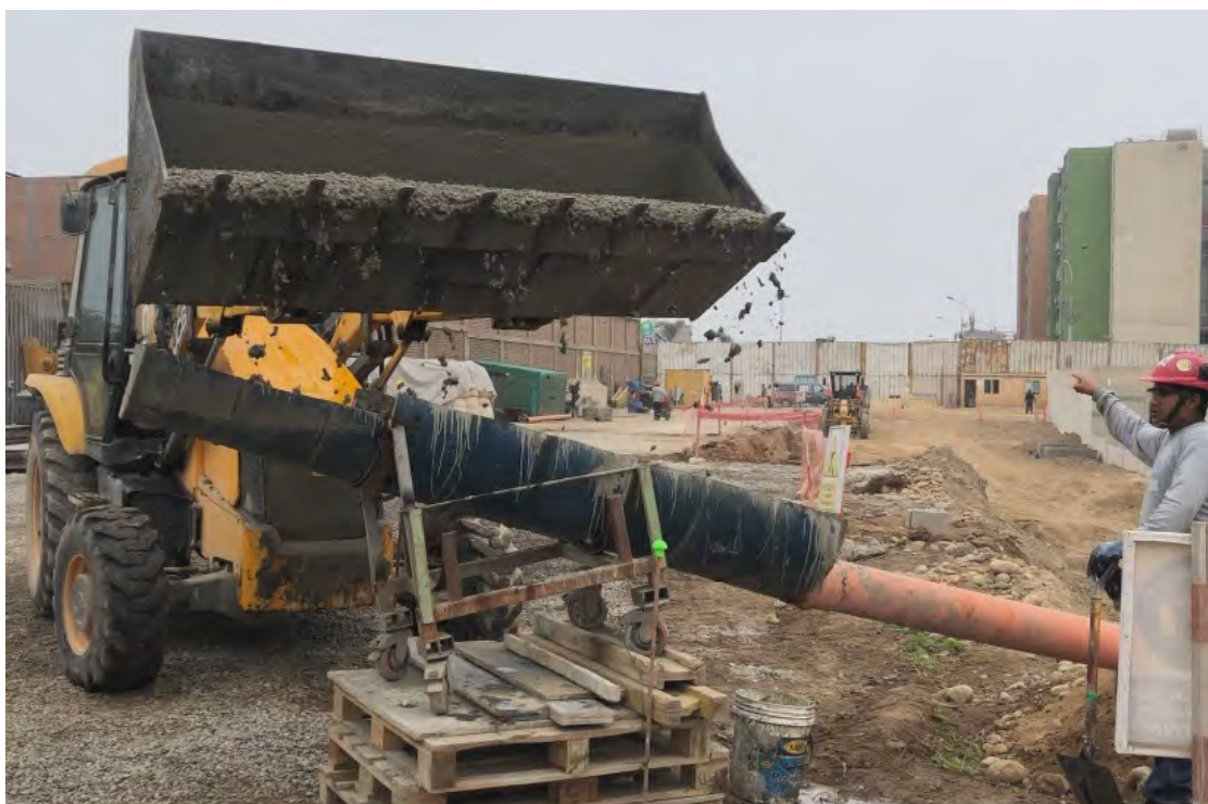
Figura 35. Fotografía del vaciado de concreto con el chute Fuente: Propia.
