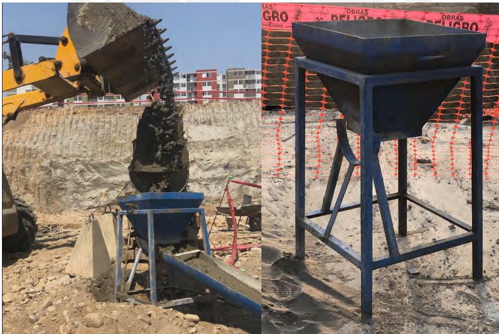
Figura 40. Embudo que recibe concreto del chute y lo transporta hacia las canaletas Fuente: Propia.
