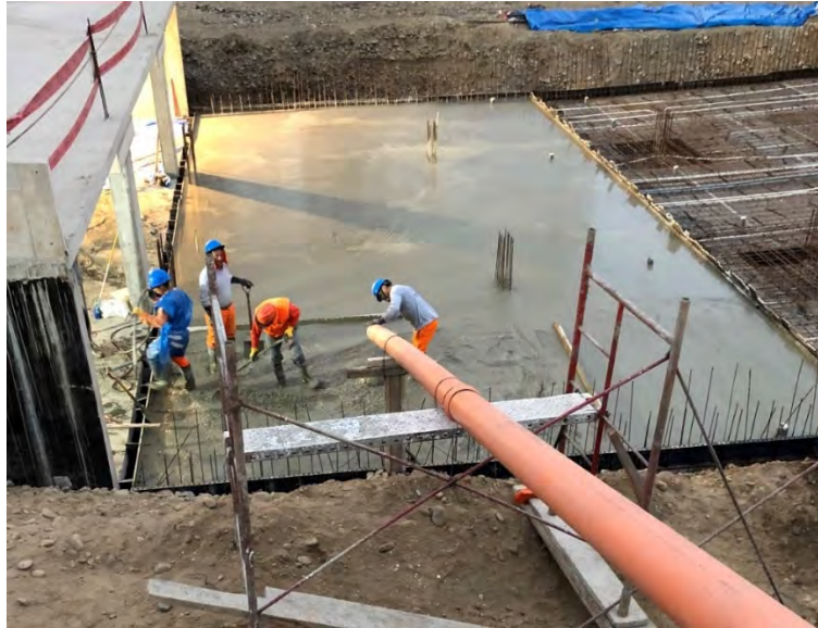
Figura 34. Vaciado de techo del sótano 2 de Villanova Etapa 3 Fuente: Propia.
