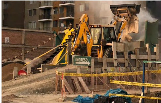
Figura 16. Retroexcavadora descargando big bag de cemento Fuente: propia.
