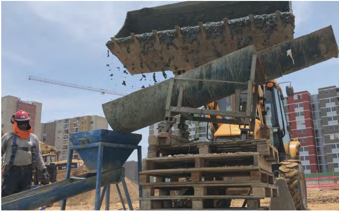
Figura 39. Vaciado con chute, embudo y canaletas Fuente: Propia
