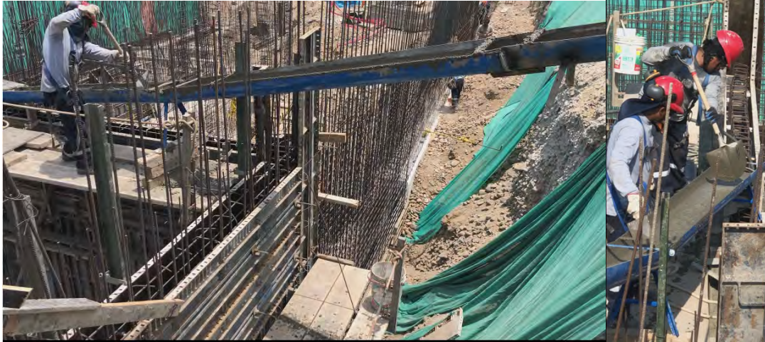
Figura 41. Concreto transportado por gravedad en canaletas
