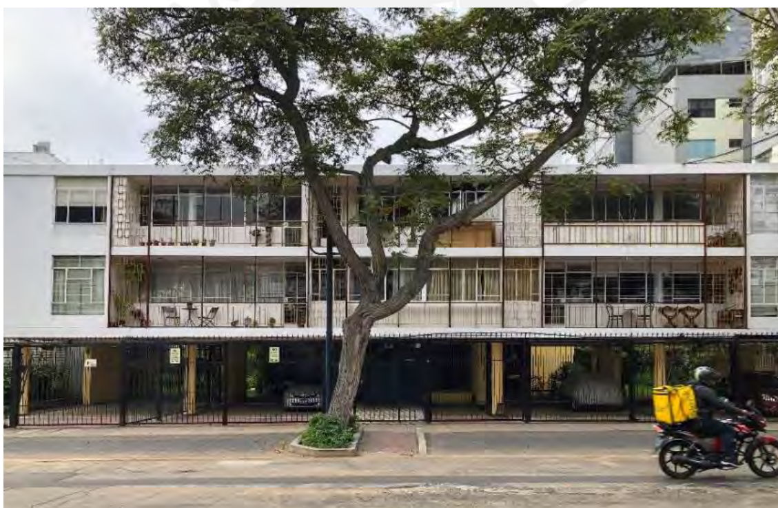
Figura 15. Vista actual de la fachada del Edificio Dos de Mayo en San Isidro. Fotografía del autor.
