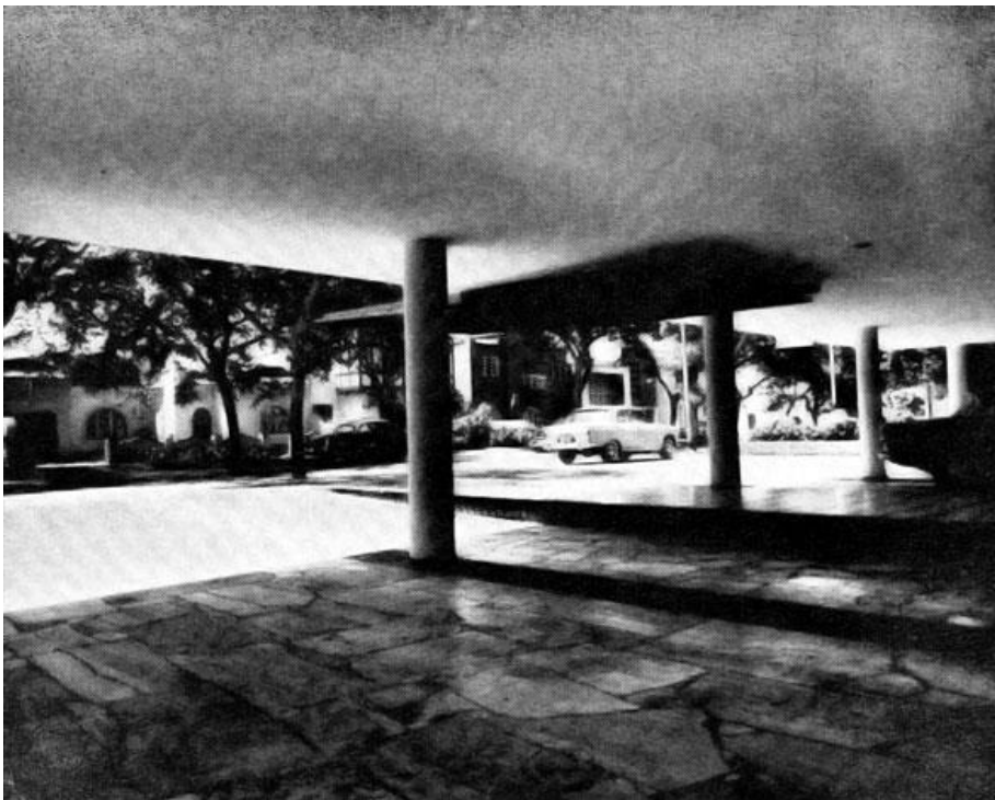
Figura 12. Vista desde la planta libre del edificio Dos de Mayo publicada en El Arquitecto Peruano (1963). Fuente: Catálogo de Arquitectura del Movimiento Moderno en el Perú.
