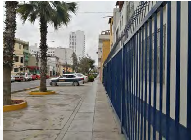
Figura 142. Fachada 2 vista peatonal Fuente: Producción propia
