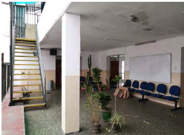
Figura 57. Circulación metálica adaptada Fuente: Producción propia
