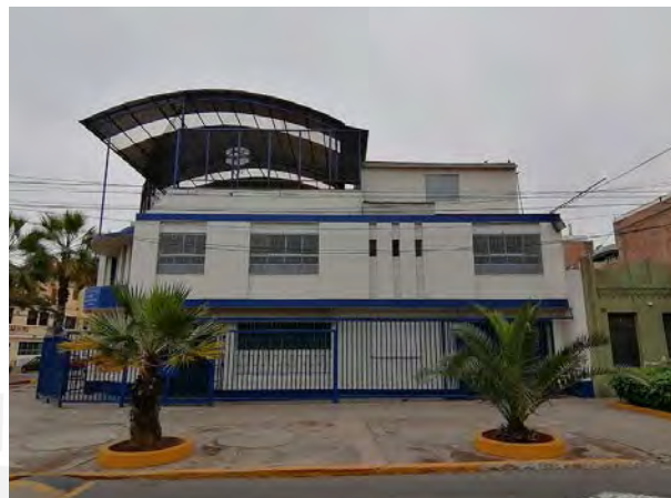
Figura 66. Vista frontal cobertura curva Fuente: Producción propia
