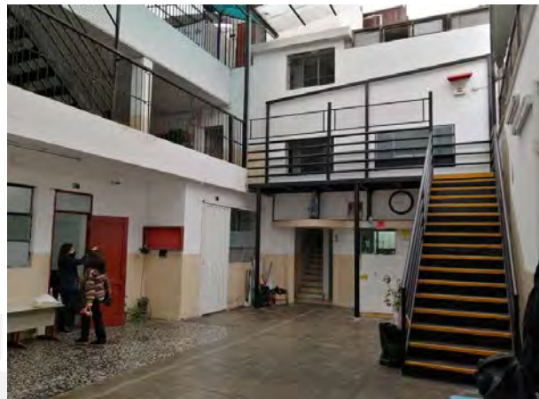
Figura 99. Escalera metálica patio 1 Fuente: Producción propia
