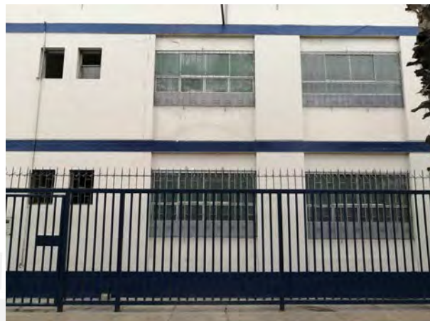
Figura 47. Rejas perimetrales del colegio fachada 2 Fuente: Producción propia
