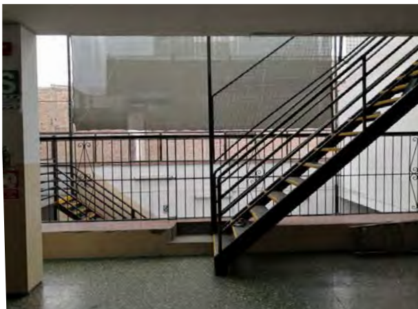
Figura 154. Escalera metálica segundo nivel 1 Fuente: Producción propia
