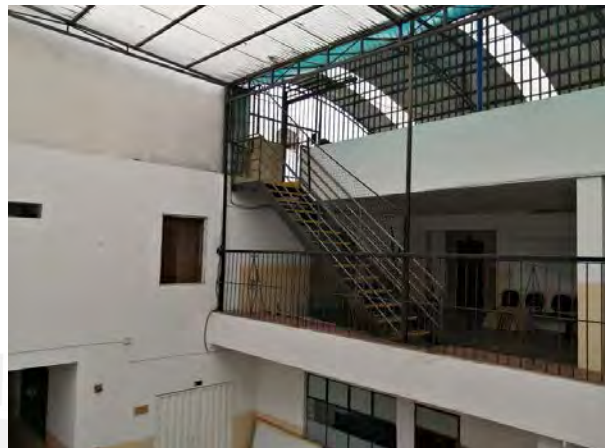
Figura 155. Escalera metálica segundo nivel 2 Fuente: Producción propia
