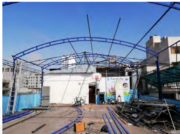
Figura 72. Renovación de cobertura metálica Fuente: Producción propia
