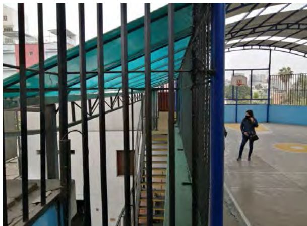
Figura 145. Vista desde el almacén de deporte Fuente: Producción propia
