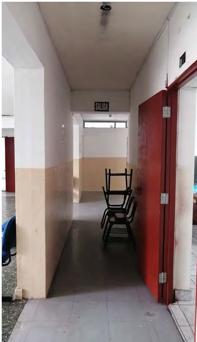
Figura 92. Corredor nivel 2 aulas Fuente: Producción propia
