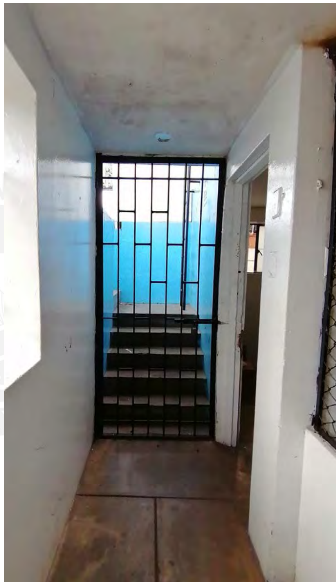
Figura 93. Corredor nivel 3 patio Fuente: Producción propia
