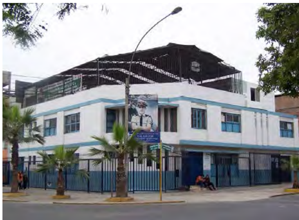
Figura 54. Cobertura metálica diagonal Fuente: Archivo Cap. FAP. José Abelardo Quiñones
