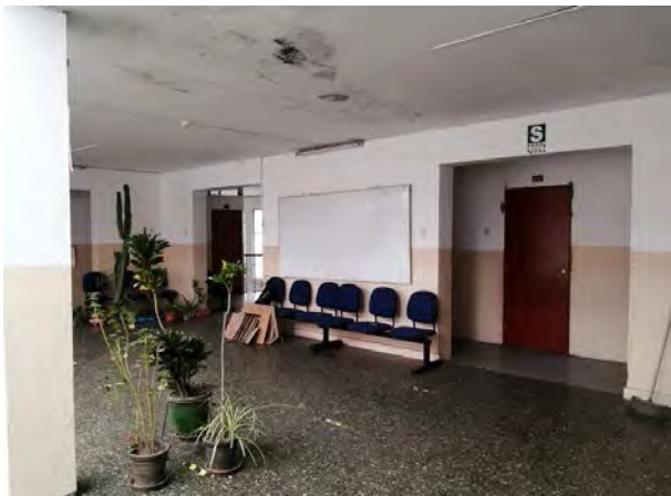
Figura 102. Patio del segundo nivel 2021
