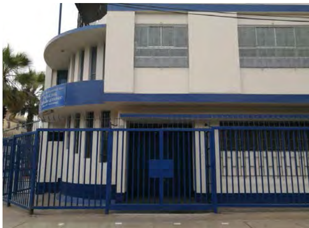
Figura 46. Rejas perimetrales del colegio fachada 1 Fuente: Producción propia
