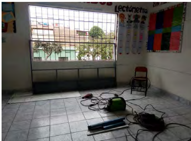
Figura 71. Renovación de ventanas antisísmicas Fuente: Archivo Cap. FAP. José Abelardo Quiñones
