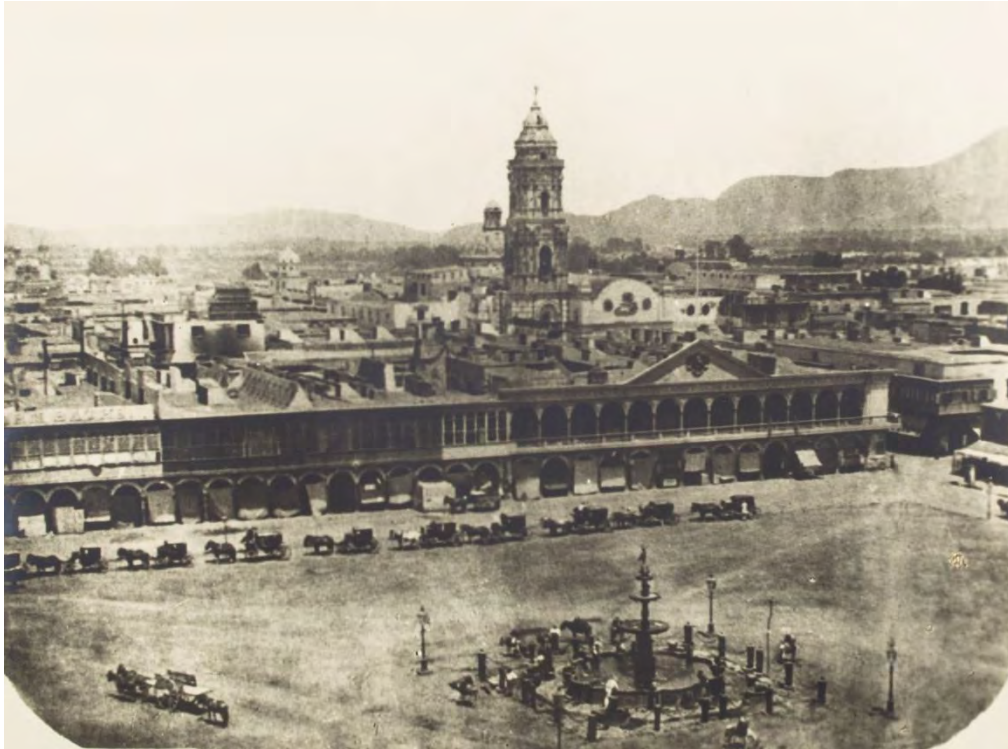
Figura 4: Fotografía de la Plaza Mayor en 1860. Se aprecia el Portal de Escribanos con los balcones neoclásicos y uniformes, la Municipalidad de Lima con el frontón triangular, instalación de los primeros alumbrados públicos, fuente de agua rodeada por bolardos y la torre del convento de Santo Domingo. Fuente: Repositorio Institucional PUCP
