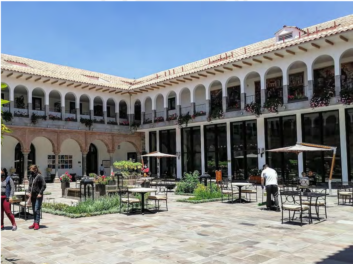
Figura N°5. La intervención final de Hotel Marriot. Se implementa dos niveles más, así como un nuevo frente de un sistema constructivo que se diferencia del anterior. Fotografía del autor.
