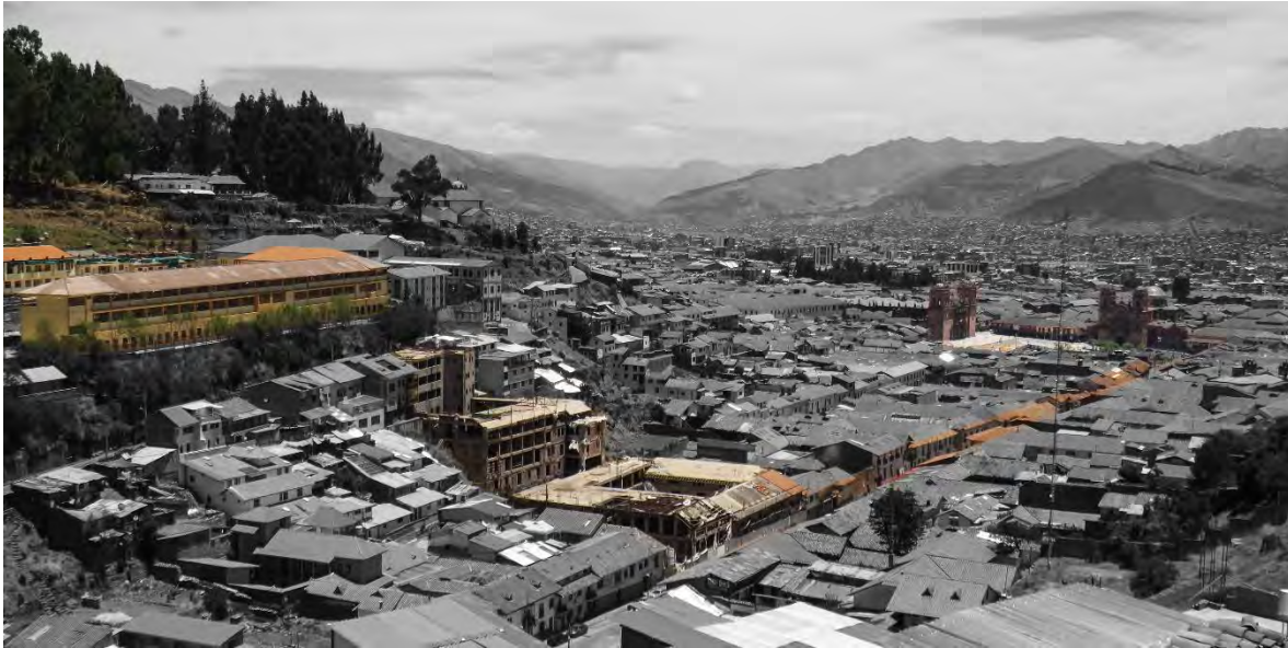
Figura N°2 El hotel Sheraton con su entorno. La gran edificación no se relaciona con su entorno y rompe con la tipología de la ciudad
