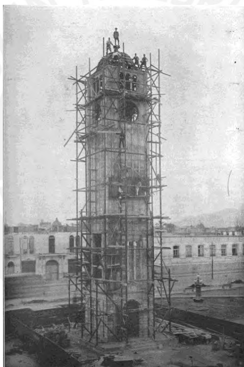
Figura 01. Proceso de construcción de la Torre del Reloj en el Parque Universitario de 1921-1923. Fuente: http://eltiempodecronos.blogspot.com/2019/07/la-torre-del-reloj-del-parque.html
