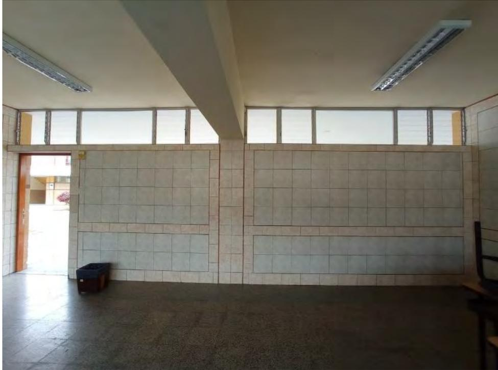
*Figura 45.* Vista interior de ventanas de 1.15 x 0.6 m adyacentes al lado de la puerta.
