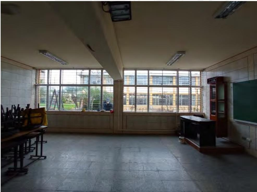
*Figura 46.* Vista interior de ventanas tipo 1 de 0.55 x 1.15 m y tipo 2 de 0.55 x 0.75 m opuestas al lado de la puerta.
