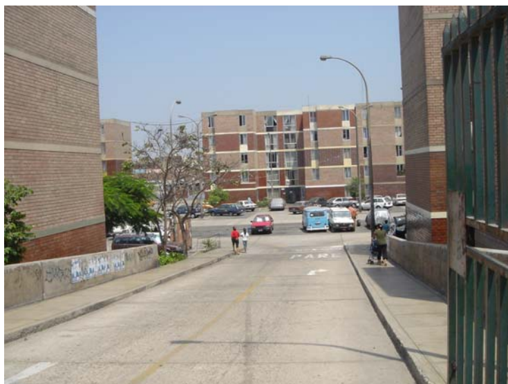
Fig.11. Imagen de la Entrada Principal
