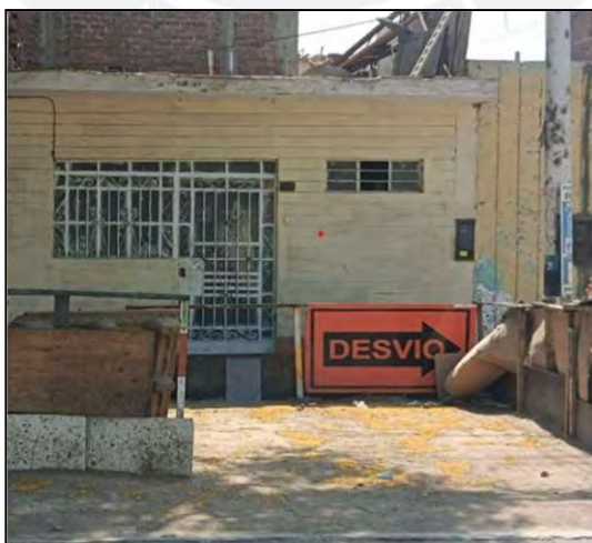
Figura 39. Muros portantes de ladrillo pandereta
