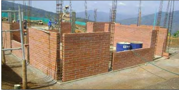
Figura 5. Construcción de muros de albañilería confinada (Olivera Smith, 2017)
