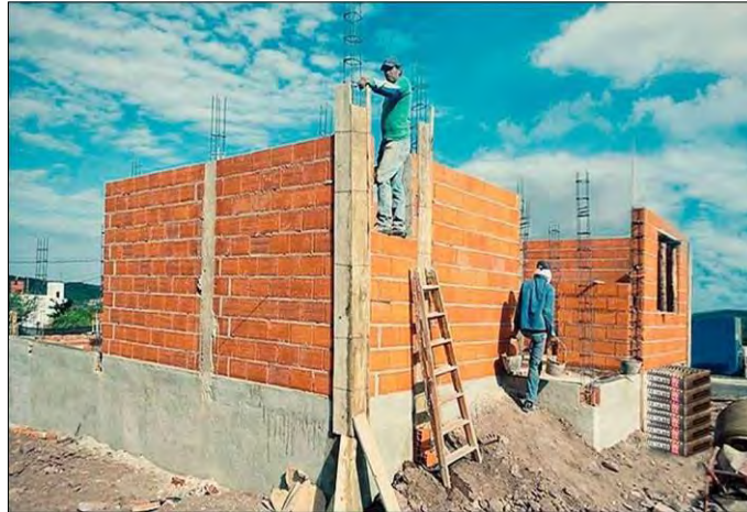
Figura 2. Construcción de vivienda mediante albañilería confinada (Cementos Inka,2018)
