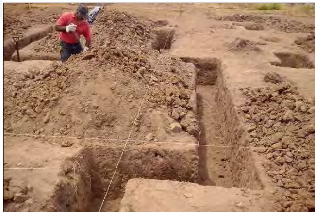
Figura 4. Zanjas para la cimentación (habitissimo,2014)
