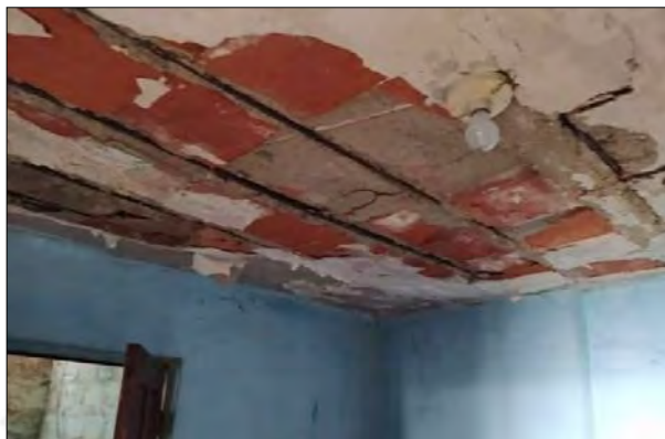
Figura 40. Acero de refuerzo expuesto
