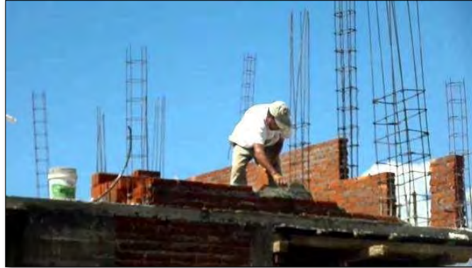
Figura 7. Construcción de muros en el segundo piso. (Laucata,2013)
