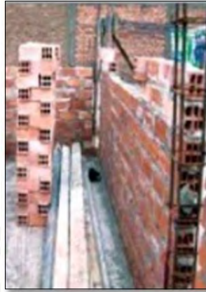
Figura 15. Muros portantes con ladrillos pandereta (Aceros Arequipa, 2021)
