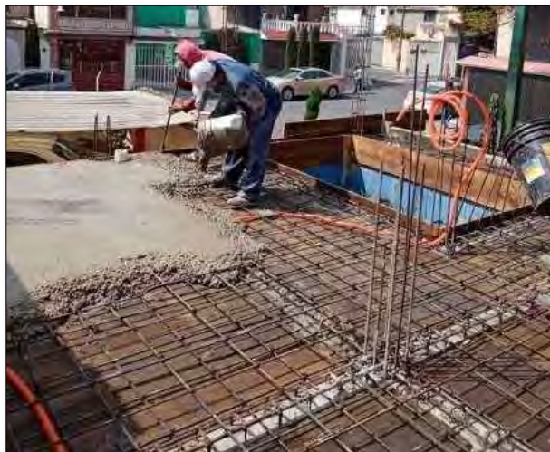
Figura 6. Construcción de losa maciza (habitissimo,2014)
