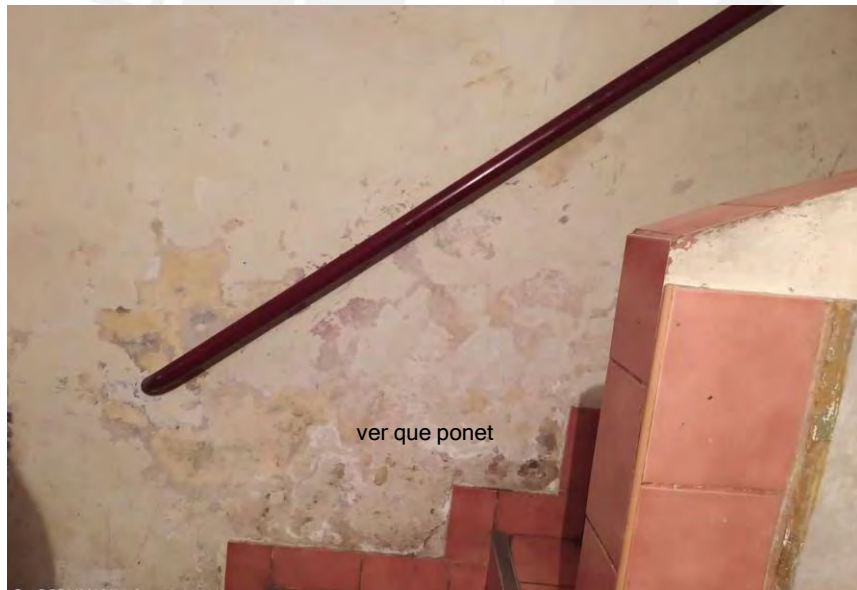
Humedad en muros
