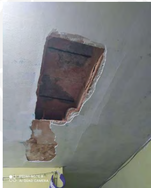
Losa aligerada expuesta
