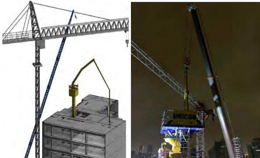
***Figura 25 . Modelo BIM para analizar actividad de obra e imagen de cómo se realizó en obra. Imagen proporcionada por staff de obra.***
