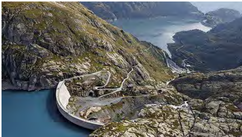
Figura 2-6 Central hidroeléctrica de bombeo
