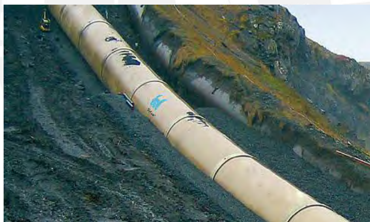
Figura 2-9 Tubería forzada de GRP en la comuna Alto Biobío
