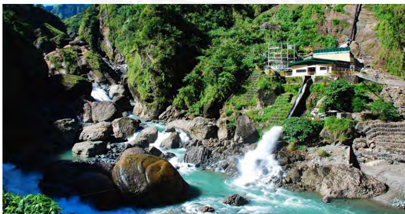
Figura 2-4 Central Hidroeléctrica de Agua Fluyente
