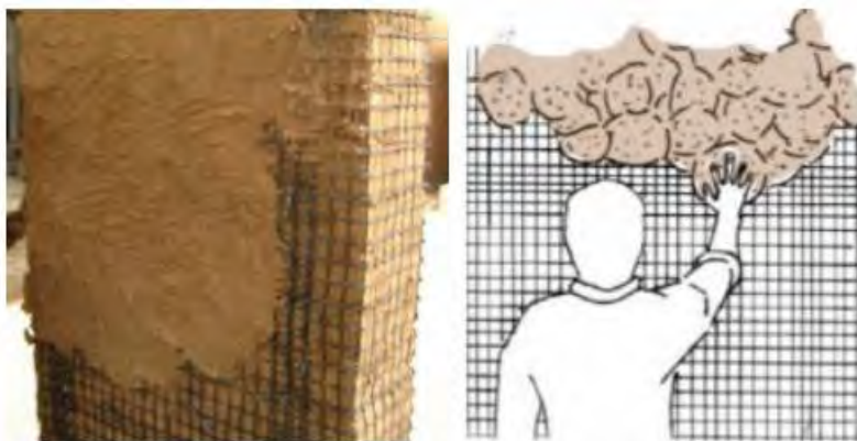
Figura 2.5 Tarrajeo de muro reforzado con malla de maguey
