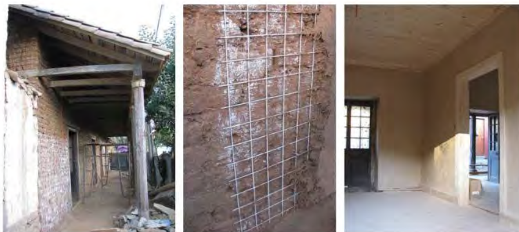
Figura 2.4 Técnica de refuerzo con malla electrosoldada
