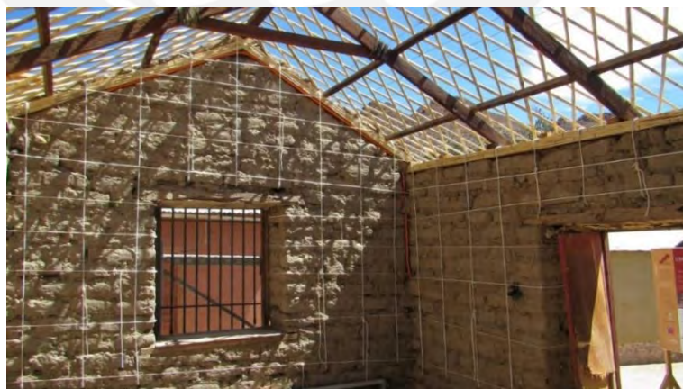
Figura 2.3 Técnica de refuerzo con sogas sintéticas (drizas)
