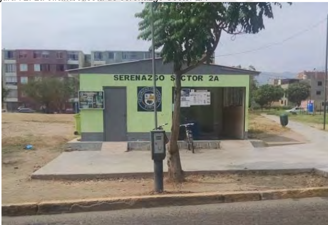
Figura 72. La oficina/caseta de serenazgo Sector 2A
