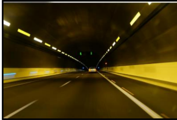
Figura 6. Paso subterráneo Fuente: Peña-García A. (2018)
