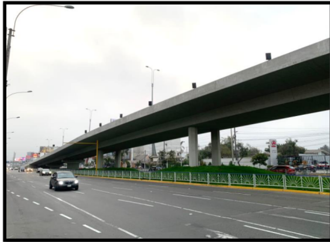
Figura 11. Primer tramo del bypass
