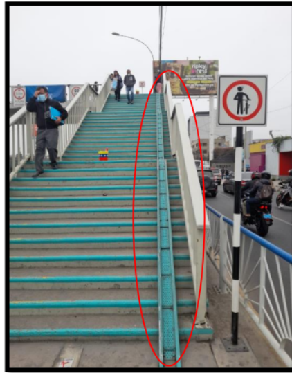
Figura 24. Rampa de acceso para bicicletas en el puente peatonal
