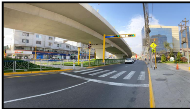
Figura 15. Tercer tramo del bypass
