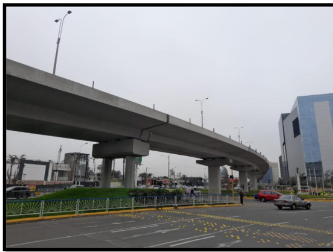
Figura 23. Ausencia de semáforos en la intersección del óvalo Monitor Huáscar
