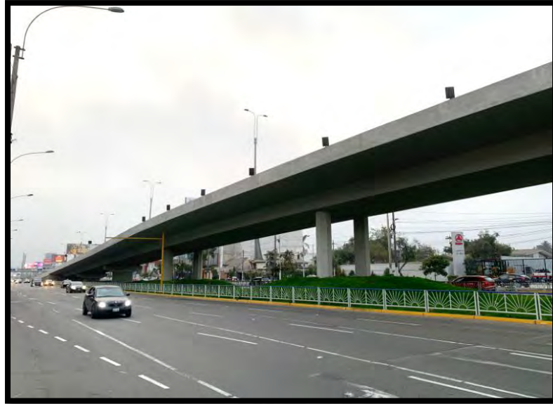
Figura 11. Primer tramo del bypass
