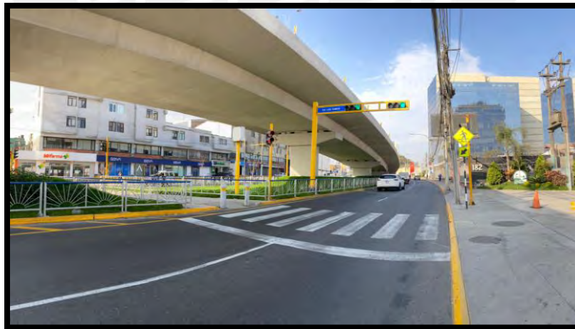
Figura 15. Tercer tramo del bypass
