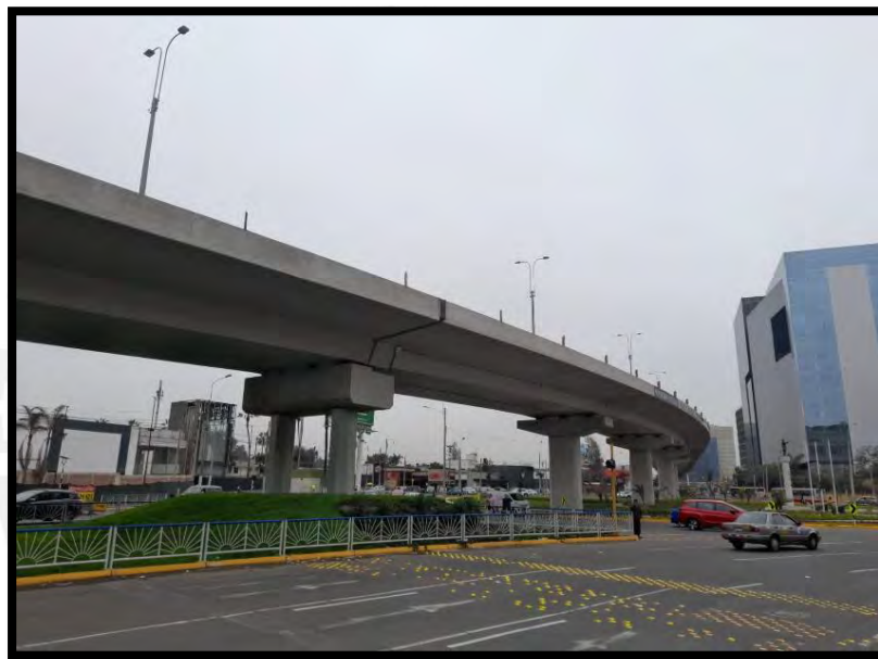
Figura 23. Ausencia de semáforos en la intersección del óvalo Monitor Huáscar Fuente Propia
