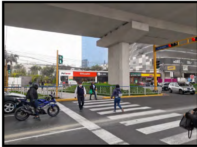
Figura 21. Cruce peatonal avenida Javier Prado sentido este – oeste Tramo 3 Fuente: Propia
