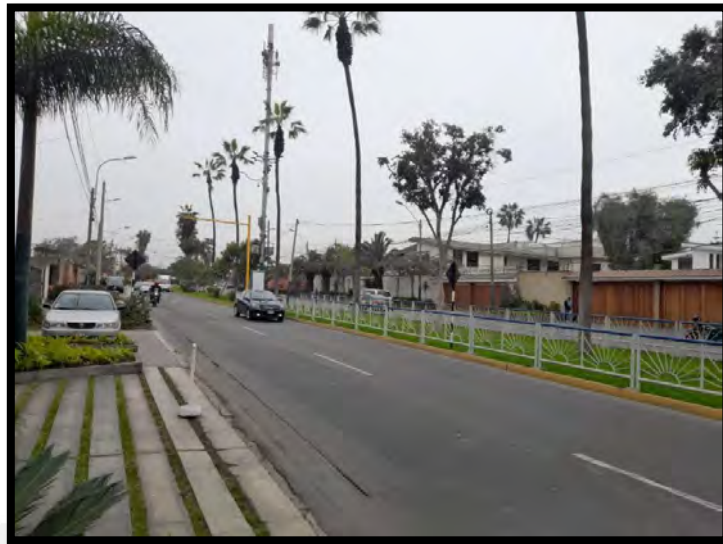
Figura 19. Falta de veredas en la avenida Las Palmeras
