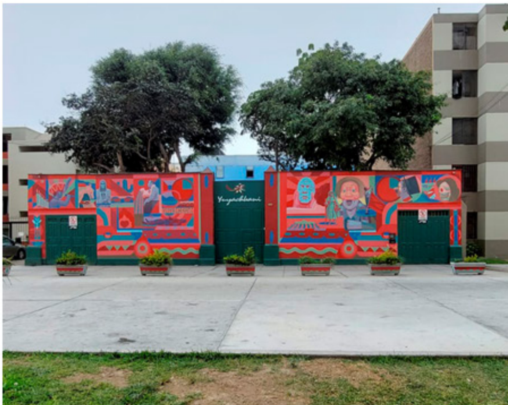
Cerramiento de fachada al exterior: limite conexión con la calle
