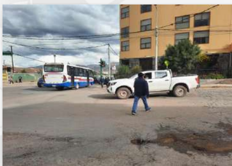
Foto 52: Vista del primer semáforo peatonal en la avenida Pardo, desde la vereda opuesta.
