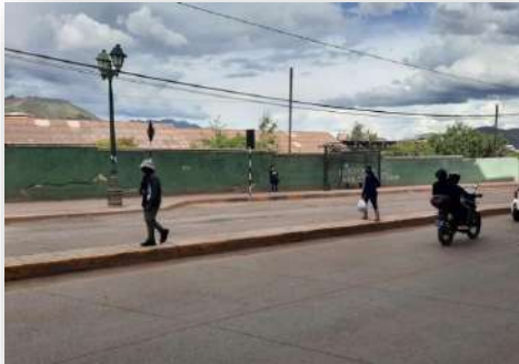
Foto 103: Carencia de canalización de peatones en la alameda Pachacutec.
