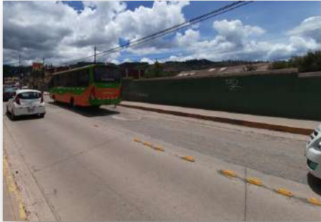
Foto 37: Tachas longitudinales removidas del pavimento de la alameda Pachacutecq.
