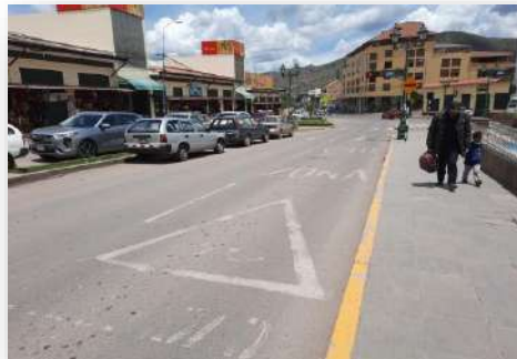
Foto 32: Demarcaciones longitudinales discontinuas desgastadas en la avenida Tullumayo.
