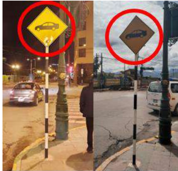
Figura 16. Señal preventiva retrorreflectiva ubicada en la intersección de estudio en horario nocturno y diurno.
