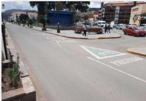
Foto 31: Demarcaciones longitudinales discontinuas en la avenida El Sol.
