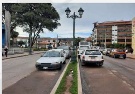
Foto 82: Ancho insuficiente de la zona de estacionamiento en la avenida Tulumayo.
