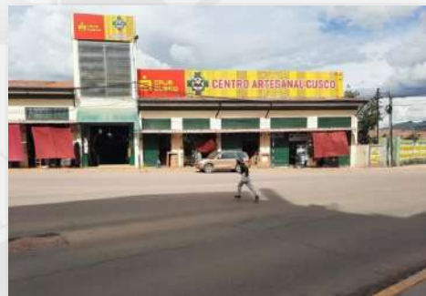
Foto 100: Carencia de canalización de peatones en la intersección.
