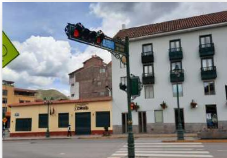
Foto 49: Semáforos peatonales en la avenida El Sol y vehicular en la avenida Tullumayo.
