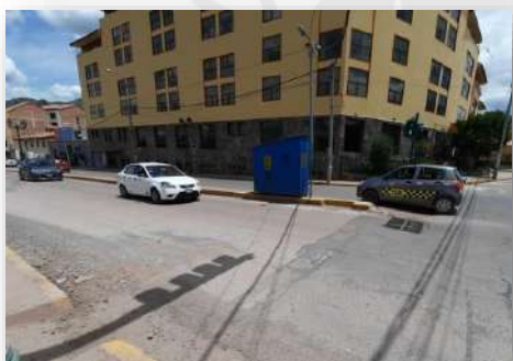
Foto 27: Ausencia de señalización horizontal en la alameda Pachacutec.
