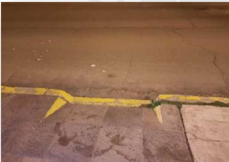
Foto 117: Visibilidad de rampa peatonal en horario nocturno, avenida El Sol.
