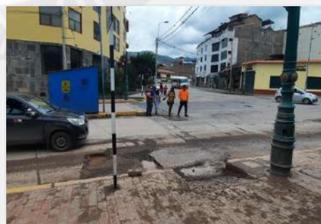
Foto 126: Mediana de dimensionamiento inadecuado en la alameda Pachacutecq.
