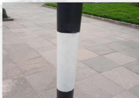
Foto 24: Soporte metálico de señalización vertical.
