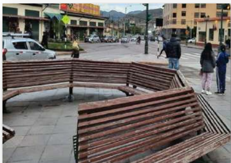
Foto 169: Bancas deterioradas en el parque “La Paccha”, avenida El Sol.
