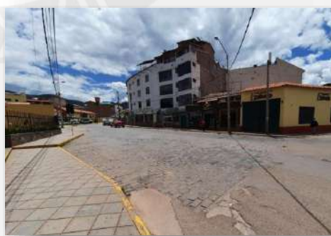
Foto 30: Ausencia de señalización horizontal en la avenida Pardo.
