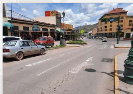
Foto 28: Señalización horizontal desgastada en la avenida Tullumayo.
