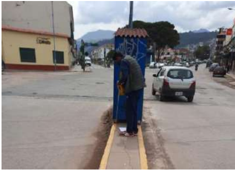
Foto 19: Demarcación del punto de referencia en la alameda Pachacutecq.
