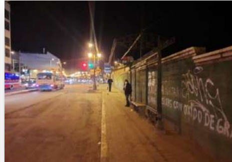
Foto 44: Iluminación deficiente en paradero de la alameda Pachacutec.
