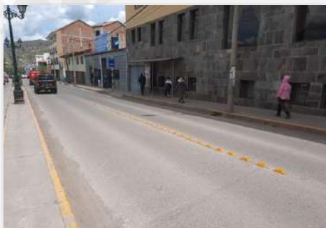
Foto 36: Tachas de demarcación longitudinal en la alameda Pachacutec.
