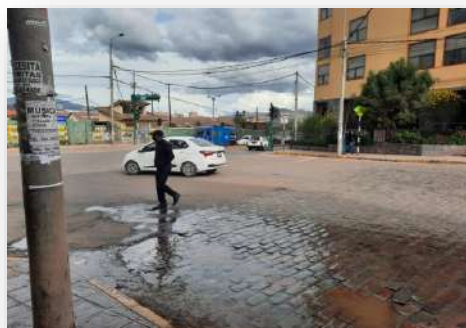
Foto 62: Zona de estancamiento de agua en la avenida Pardo.
