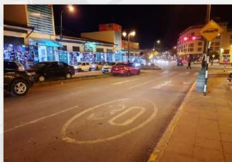
Foto 34: Visibilidad nocturna de las demarcaciones longitudinales discontinuas desgastadas en la avenida Tullumayo.
