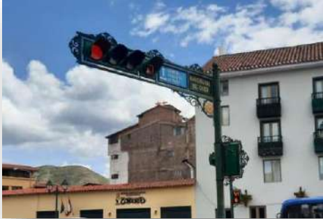
Foto 19: Señal vertical de destino ilegible, colocada al costado del semáforo de la avenida Tullumayo (fondo azul).
