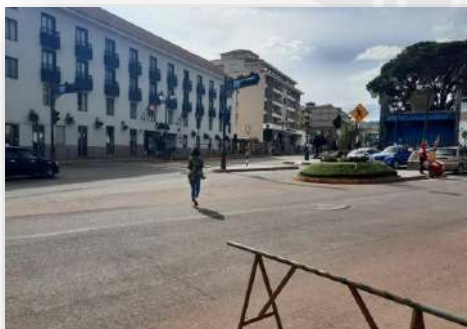
Foto 101: Carencia de canalización de peatones en la intersección.
