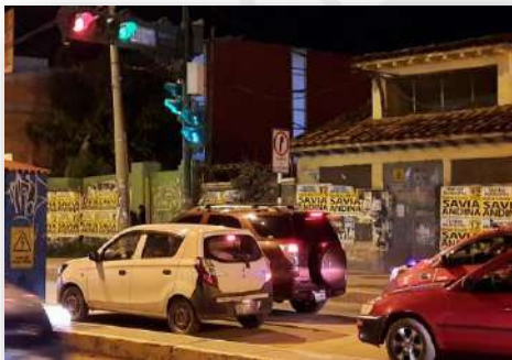
Foto 45: Visibilidad de señales verticales y semáforo en la alameda Pachacutec.
