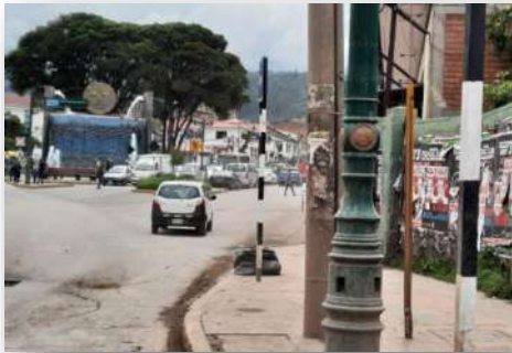
Foto 13: Señalización vertical con visibilidad reducida por su orientación en la alameda Pachacutecq.
