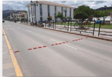
Foto 38: Tachas reductoras de velocidad en la avenida El Sol.
