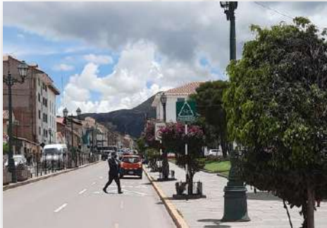
Foto 15: Señalización vertical con visibilidad obstruida por el arbolado urbano en la avenida El Sol.
