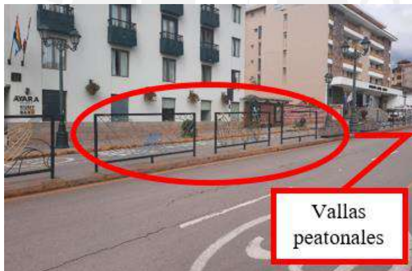
Figura 44. Vallas peatonales ubicadas para separar carriles en la avenida "El Sol". Fuente: propia.
