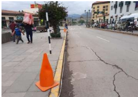
Foto 7: Colocación del cono 2 en el punto 2.
