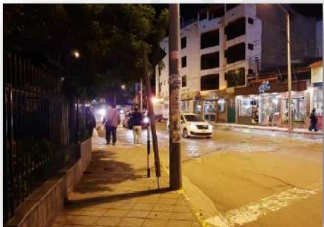
Foto 165: Postes de cableado eléctrico ubicados en el borde de la acera, avenida Pardo.
