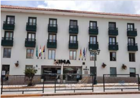
Foto 21: Hotel XIMA en la avenida El Sol.
