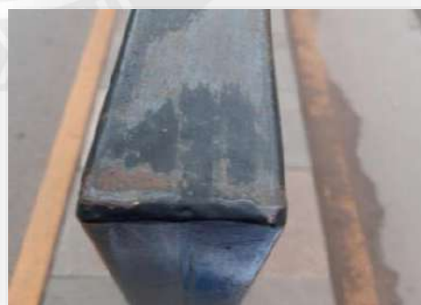
Foto 162: Vallas peatonales fabricadas con acero en la avenida El Sol.
