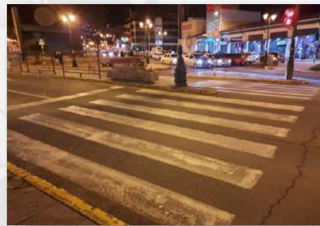
Foto 118: Visibilidad de cruce peatonal en horario nocturno, avenida El Sol.
