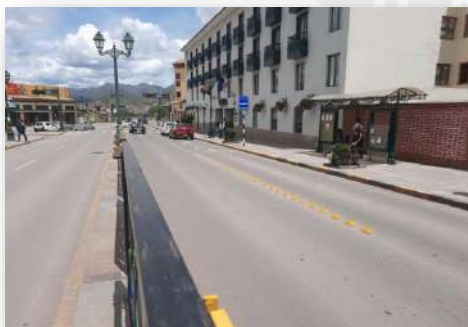
Foto 35: Tachas de demarcación longitudinal en la avenida El Sol.
