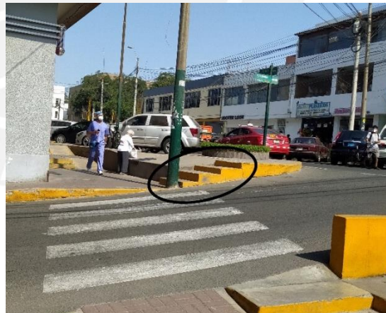
Figura 39: Escalera en acera de esquina. Fuente: Propia (2021)
