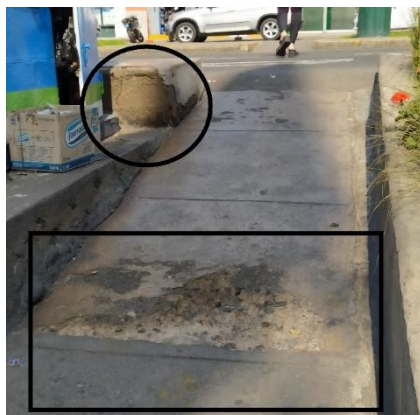
Figura 26: Detalle de rampa. Fuente: Propia (2021)
