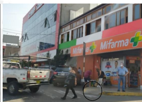
Figura 19: Deficiencias en esquina en Av. La Encalada. Fuente: Propia (2021)
