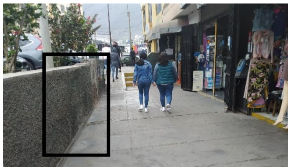
Figura 59: Muro en acera Jr. El Álamo. Fuente: Propia (2021)
