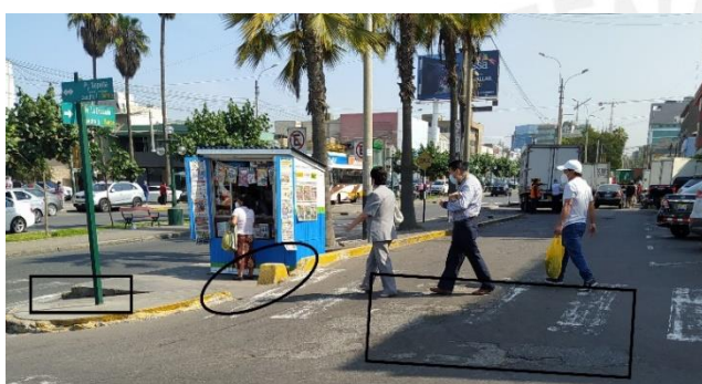
Figura 18: Deficiencias en cruce en Av. La Encalada. Fuente: Propia (2021)
