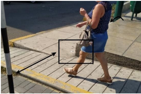
Figura 53: Rampa de paradero. Fuente: Propia (2021)
