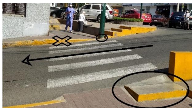
Figura 43: Cruce en pendiente en zona 2. Fuente: Propia (2021)
