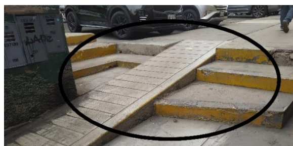
Figura 40: Escalera y rampa muy angosta en acera de Jr. El Álamo. Fuente: Propia (2021)
