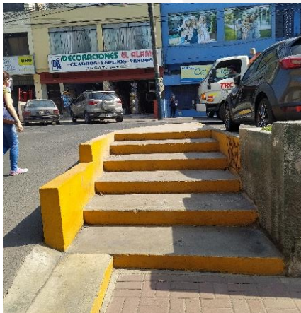
Figura 38: Escalera en acera Jr. El Álamo. Fuente: Propia (2021)
