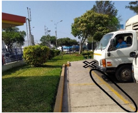
Figura 47: Acera insegura frente a estacionamientos. Fuente: Propia (2021)
