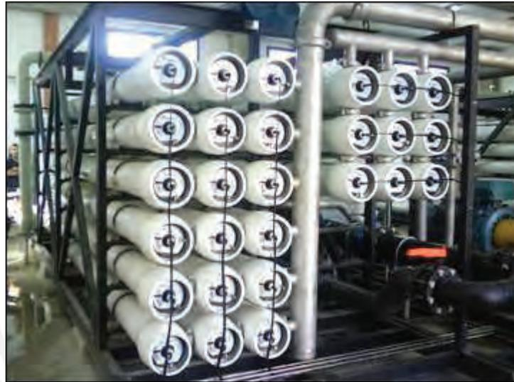
**Figura 2.4.** Bastidor de ósmosis inversa
