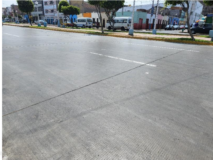
Figura 24. Pavimento rígido existente.
