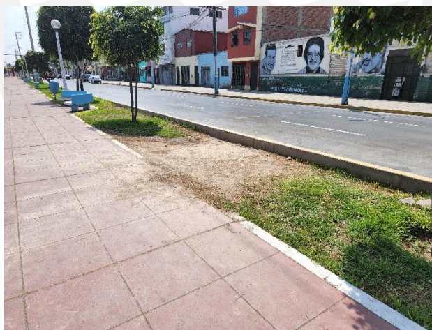
Figura 28. Daño en áreas verdes producto de cruce peatonal informal.
