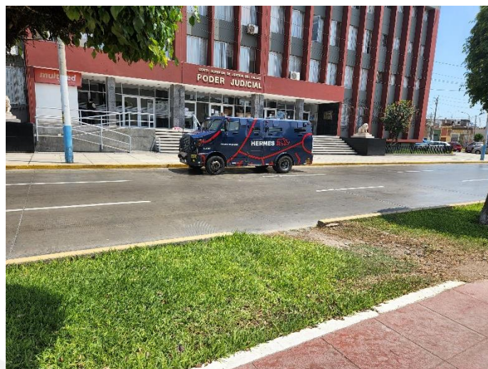
Figura 27. Daño en sardinel de concreto y áreas verdes producto de cruce peatonal informal frente a Poder Judicial.
