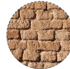
Muros de Adobe
