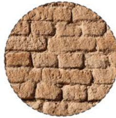
Muros de Adobe
